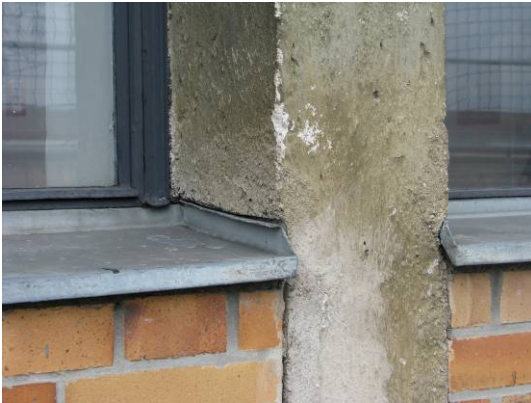
Abbildung 46: unterschiedliche Modellierung der Aufkantung eines Fensterbleches
