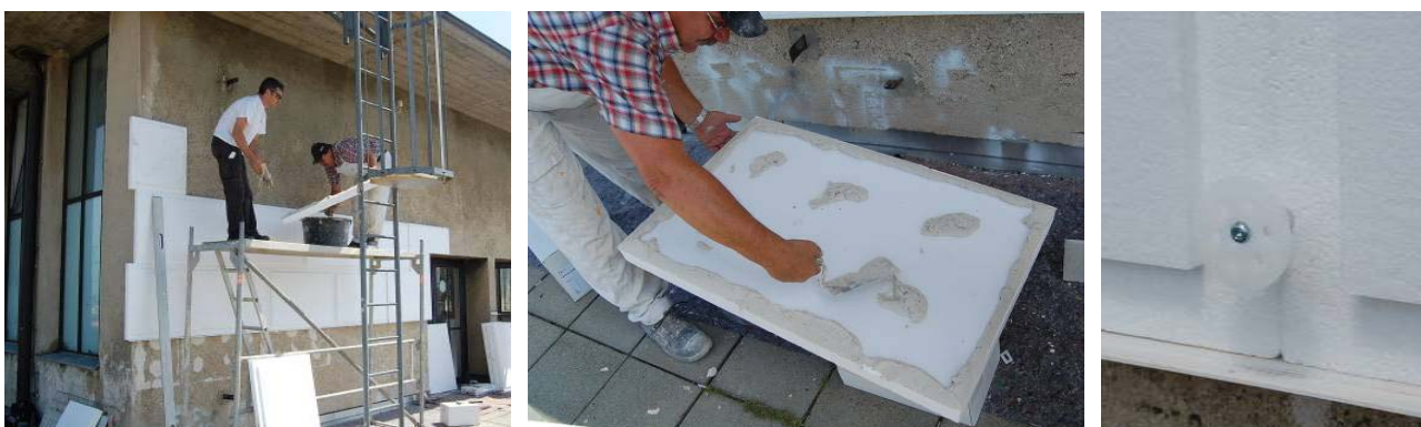
Abbildung 110: Anbringen der Dämmelemente (links), Auftragen des Klebemörtels (Mitte), Verdübelung (rechts)
