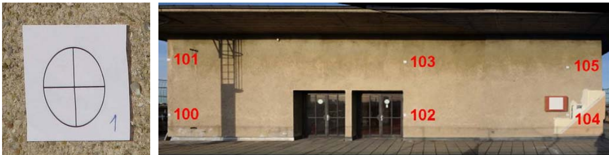
Abbildung 87: Messmarken an der Südfassade Vorhoelzer-Bau, Detail (links) und Gesamtansicht mit Nummerierung der Marken (rechts)
