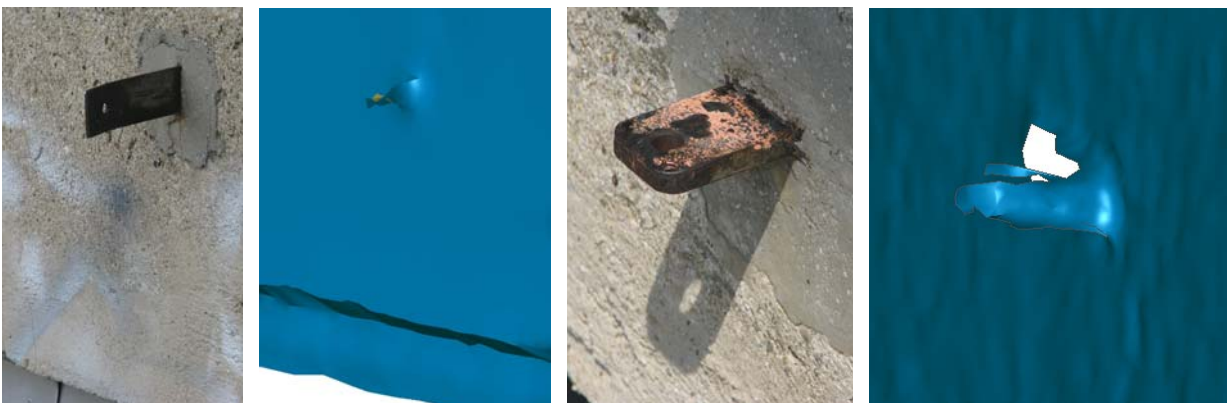
Abbildung 38: Vergleich Foto mit Netzmodell - ungenügend vermaschte Detailpunkte
