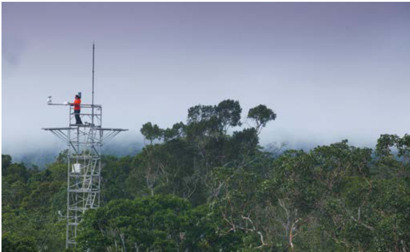
Zentraler Messturm in der Mitte des im sich Aufbau befindenden CO 2 -Rings
