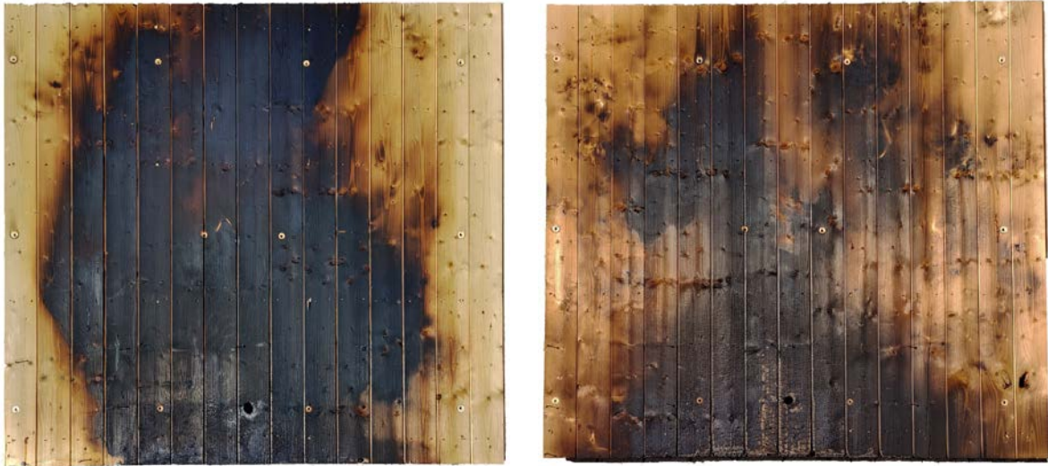
Abbildung 3.21 Fotodokumentation der Holzschalung oberhalb der Brandsperre nach Beendigung des Versuches und der Beobachtungszeit für Test 2 (links) und Test 3 (rechts)
