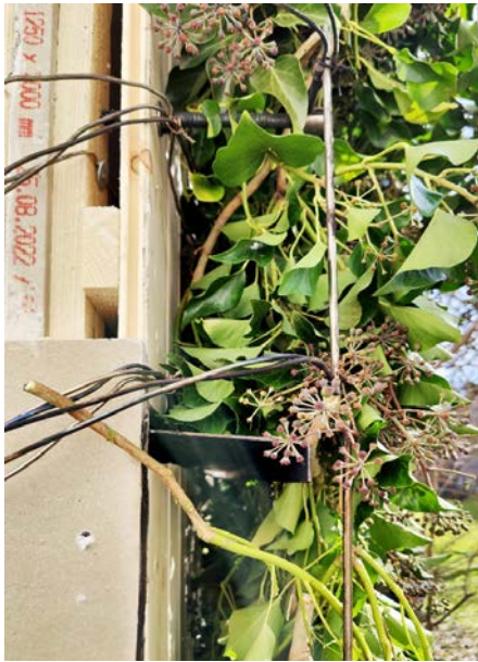
Abbildung 3.13 Fotodokumentation der Seitenansicht mit Anordnung der Begrünung und Brandsperre
