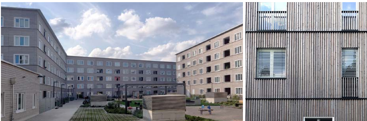
Abbildung 2.8 Beispiele für Holzfassaden, links horizontale Lärchen-Stülpchalung (WA13 Prinz-Eugen-Park München), rechts vertikale Deckleistenschalung (WA15 Ost Prinz-Eugen-Park München)
