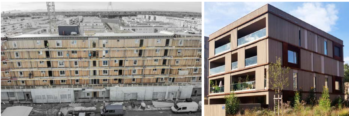
Abbildung 2.6 Beispiele für mehrgeschossigen Holzbau, links RIO – Riem Ost München (Massivholzbauweise) (Quelle: Lukas Reumschüssel), rechts WA 14 Ost Prinz-Eugen-Park München (Kombination Holztafelbau- & Massivholzbauweise)
