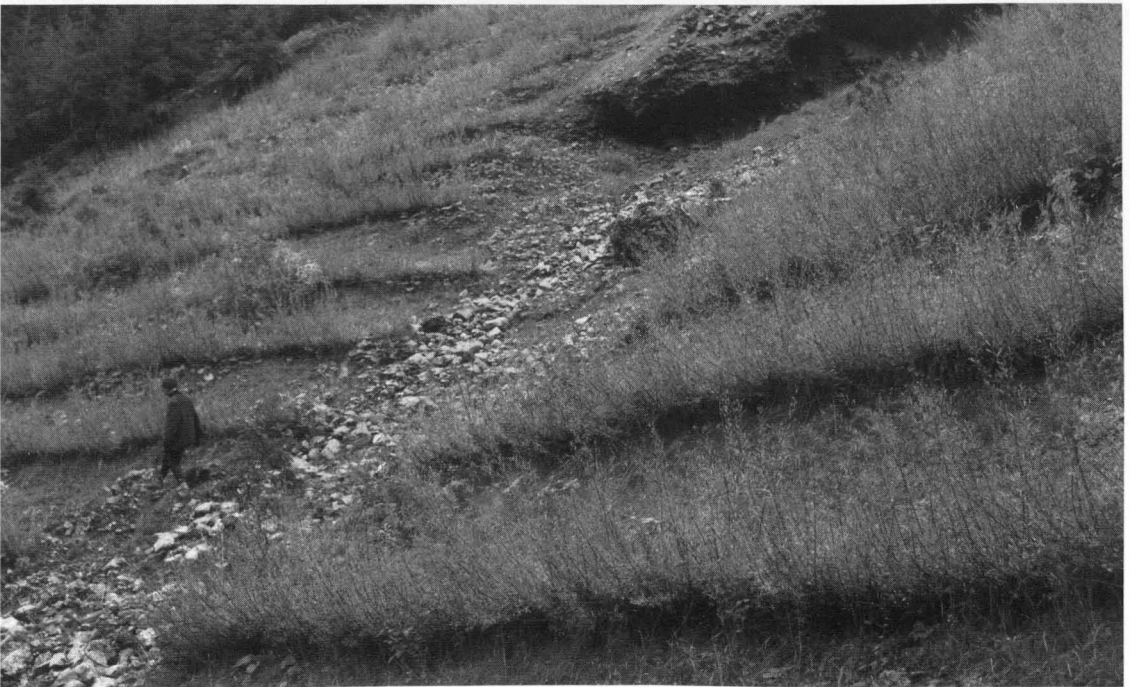
Abb. 5: Ingenieurbiologische Sanierung eines Rutschhanges durch Gehölzpflanzung in Kombination mit technischer Verbauung. Langfristiges Ziel ist eine stabile Wiederbestockung der Fläche
