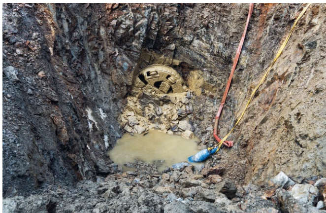
Fig. 4 Breakthrough of the TBM in the reception pit. The monoblock double-ring face and caliber cutters are visible. Bild 4 Durchbruch der TBM im Zielschacht. Die Monoblock-Zweiring-diskens und Kaliberdiskens sind sichtbar.
