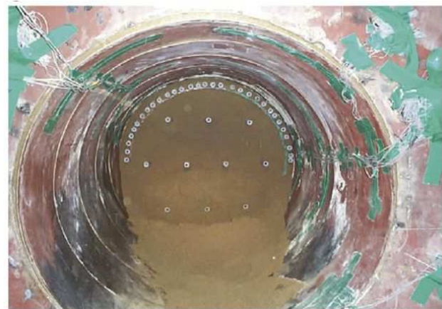
Abb. 4-17: Blick auf die Ortsbrust mit vorausseilenden Sicherungsmitteln (SHIN et al. 2008)
