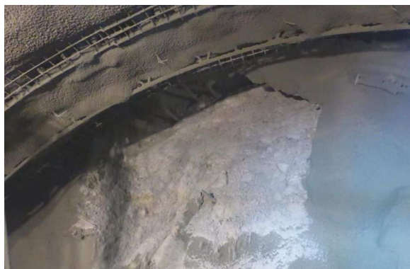
Abb. 4-21: Versagen der lokalen Gewölbe (Ausrieseln von Bodenkörnern)
