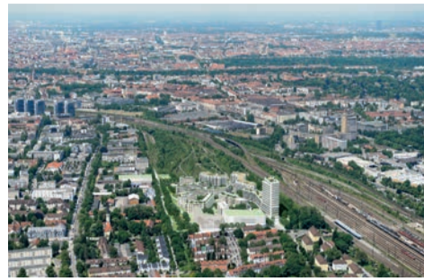
Das neue Wohngebiet "Baumkirchen Mitte" in Berg am Laim: Ansicht Ost, im Hintergrund die Münchner Innenstadt und der Hauptbahnhof; Visualisierung: © CA Immo Deutschland
