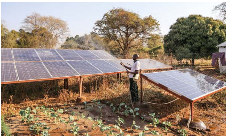
Regelmäßige Reinigung und Wartung einer Photovoltaikanlage in Simbabwe. © Stephan Baur
