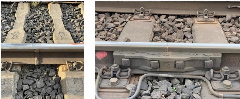
Abb. 35: Beispiel für Schienenverbindungen mit Ausführung als Schienenschweißstoß (Links) und Isolierstoß (Rechts)
