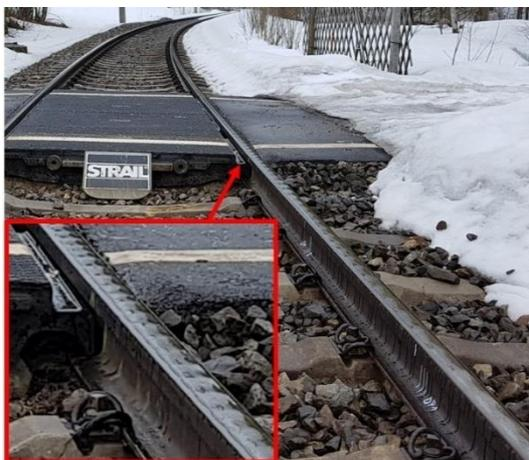
Abb. 39: Ausbildung von Schlupfwellen auf der Schienenoberfläche
