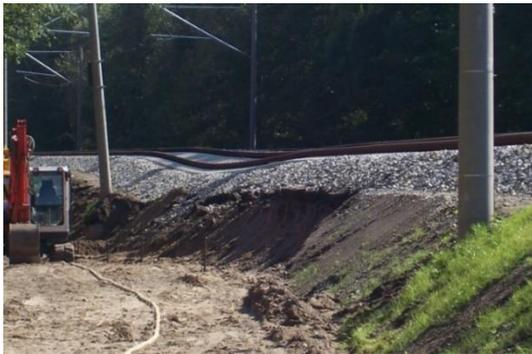
Abb. 31: Gleislageveränderung durch punktuelle Setzungen am Fahrbahnsystem
