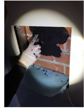
(c) Applikation der Absorber-Klebeschicht auf dem Vollziegelmauerwerk in der Wandprobenhalterung.
