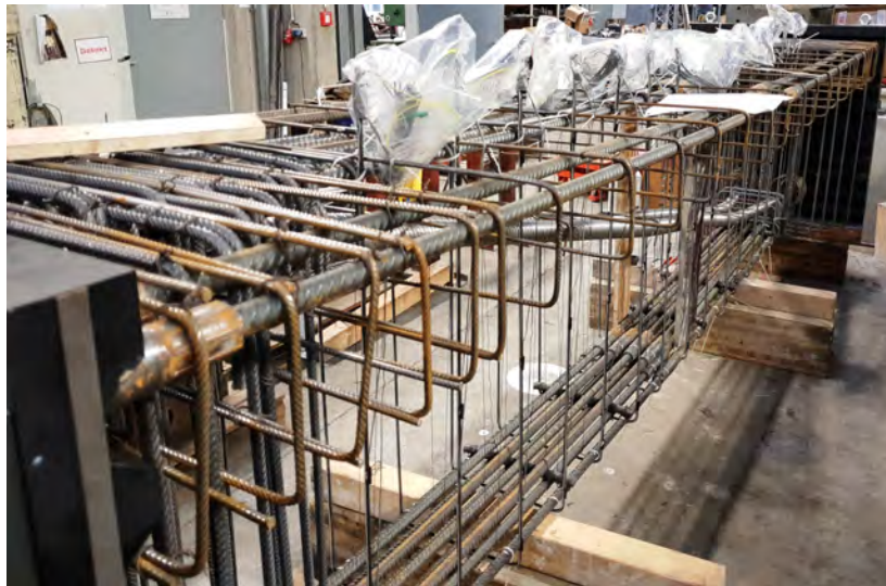
Abbildung 3.18: Bewehrungskorb von Versuchsträger PB2-gB mit faseroptischen Messfasern entlang der Querkraftbewehrungselemente
