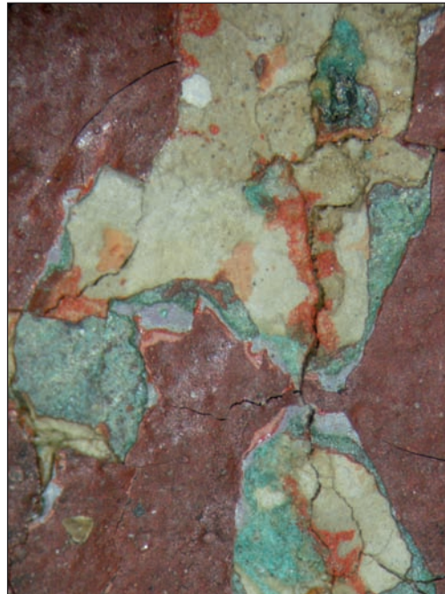
Abb. B 159: Bischof 351, Mikroskopaufnahme aus der Fassung des Pluvialfutters: grüne Schicht der ersten Überfassung liegt teils direkt auf der Grundierung der Erstfassung
