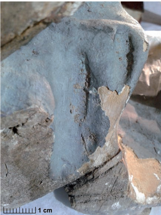
Abb. B 50: Bischof A 346, Detail Faltenwurf der Albe (Untersicht) auf linker Körperseite: grobe Schmutzablagerungen (Arbeitsaufnahme Vorzustand)
