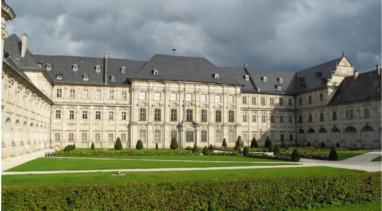
16: Westfassade, Foto: Franzfoto
