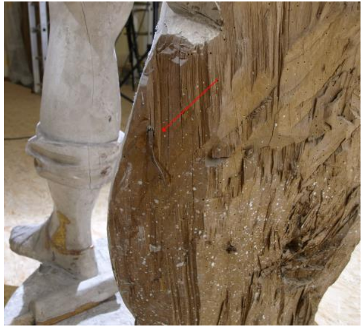
155: Nagel auf der Rückseite des Schildes
