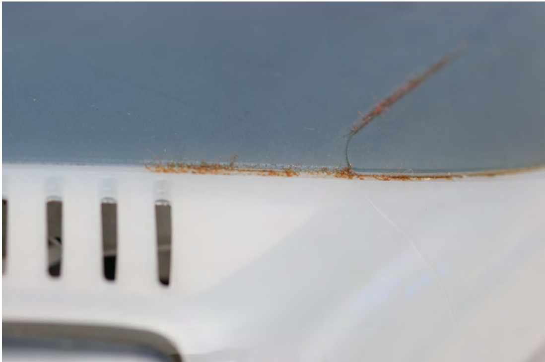
Abbildung A.30: Schmutzansammlung innerhalb der Fugen an der Unterseite.
