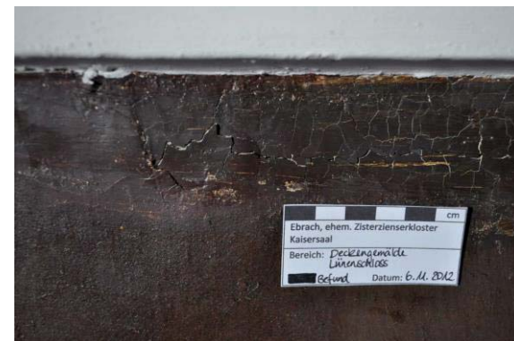
Abb. 169: Riss in der Retusche zum Stuckrahmen.
