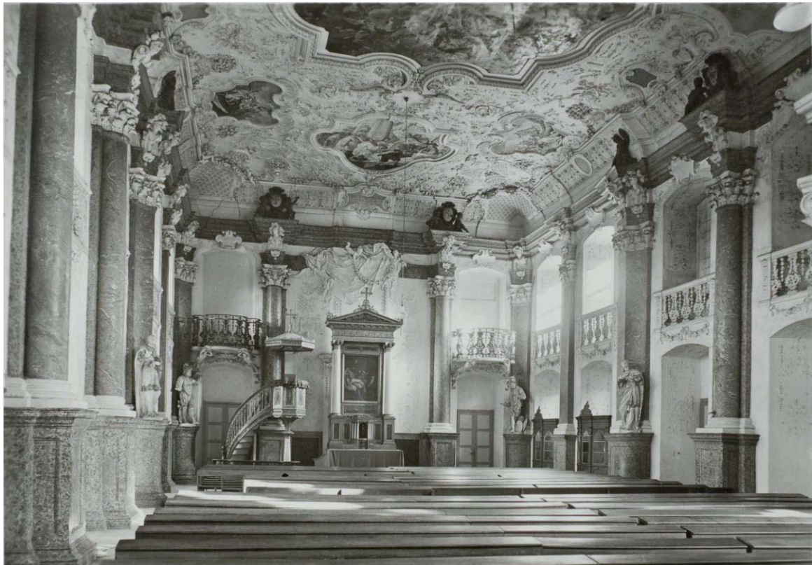
Abb. 140: Kaisersaal: Aufnahme aus den 1930er Jahren, vor Abnahme und Drehung des Gemäldes. Blick nach Norden, Notsicherungen am Deckengemälde von LÜNENSCHLOSS [Bildarchiv des Bayerischen Landesamtes für Denkmalpflege München 2013].
