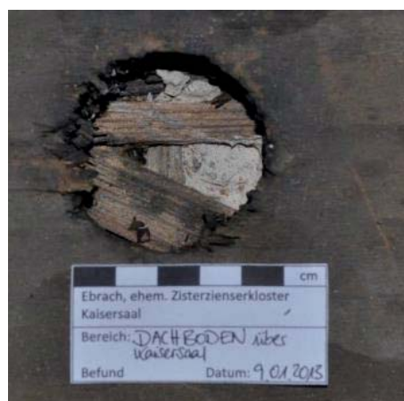
Abb. 75: Öffnung in der Holzschalung der Kaisersaaldecke mit Sicht auf quer verlaufende Holzleisten und den Grundputz.
