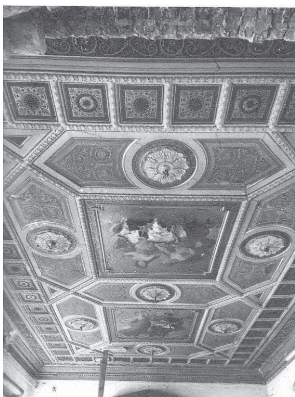
Abb. 162: Wien, Schottenring 10, Decke mit Ma- roufragebildern von KARL GEIGER 1871, Aufnahme um 1970 vor Abnahme der Gemälde [KOLLER/VIGL 2005, S. 183].
