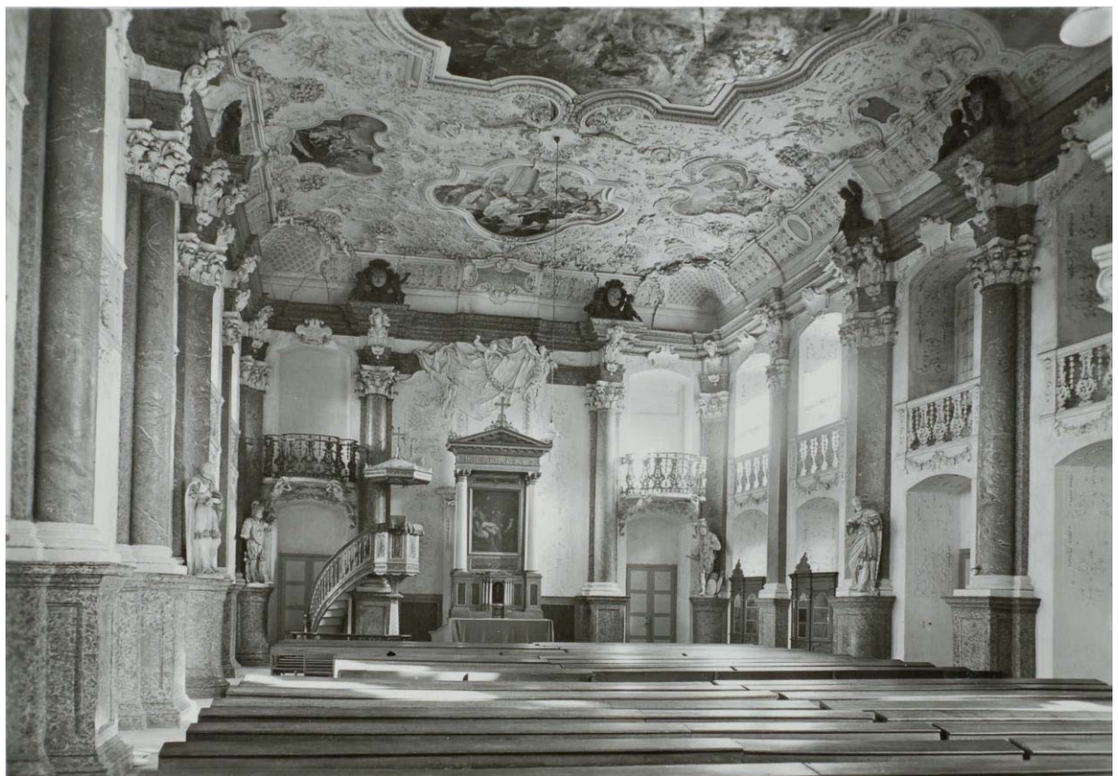
Abb. 85: Aufnahme des Kaisersaals aus den 1930er Jahren, Blick nach Norden, Notsicherungen an Deckengemälde von LÜNENSCHLOSS [Bildarchiv des Bayerischen Landesamtes für Denkmalpflege München 2013].
