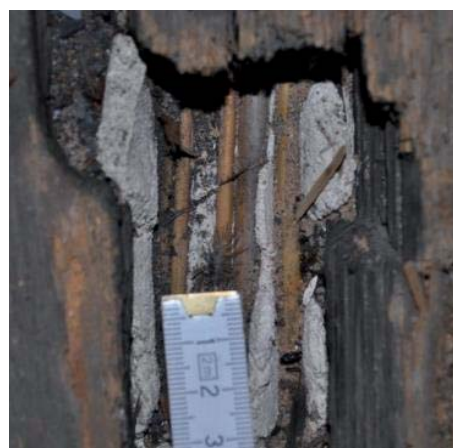
Abb. 74: Öffnung in der Holzschalung der Kaisersaaldecke mit Sicht auf die Schilfrohrarmierung (mit Draht umwickelt) des Grundputz.
