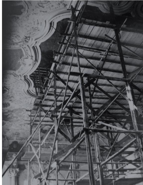
Abb. 82: Gerüst im Kaisersaal bei der Restaurierung des Gemäldes 1938 [Nachlass MAYER & RIEDHAMMER, Stadtarchiv Bamberg D 5016 4304–25].
