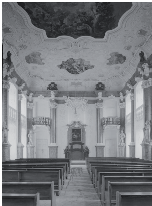
Abb. 13: Aufnahme des Kaisersaals von 1971, Blick nach Süden.
