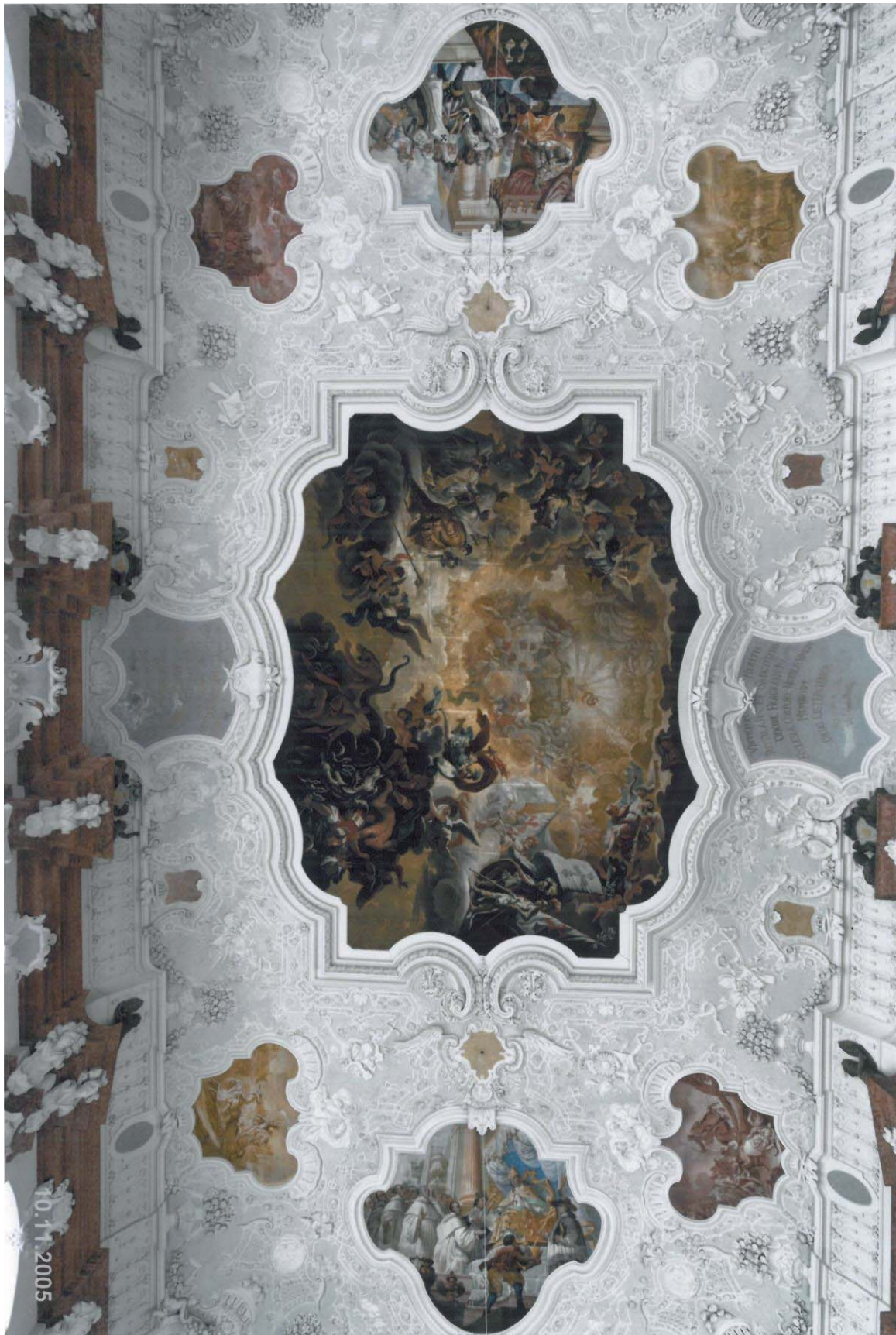
Abb. 142: Übersicht der Stuckdecke im Kaisersaal, ehem. Zisterzienserabtei Ebrach vom 10.11.2005 [NEUSTADT 2008, S. 21].
