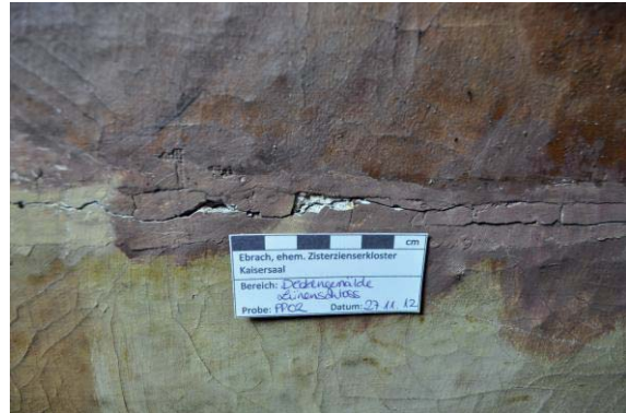
Abb. 120: Heraus gebrochene Kittung über den Leinwandstößen.
