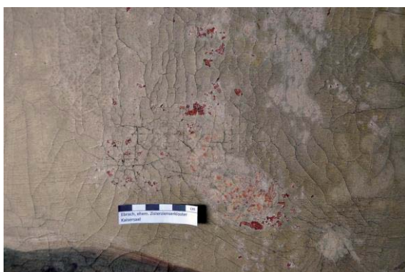
Abb. 128: Fehlstellen in der Malschicht und der 2. Grundierung, intakte rote Grundierung.
