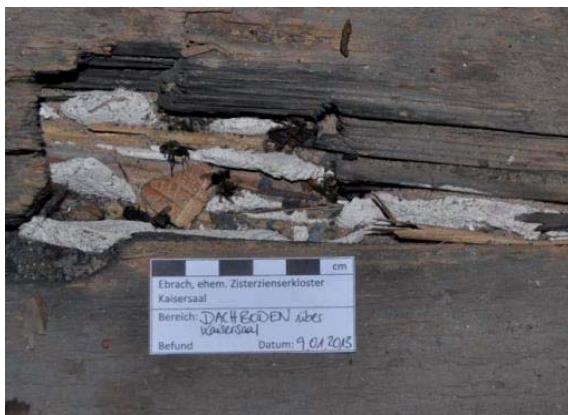
Abb. 73: Öffnung in der Holzschalung der Kaisersaaldecke mit Sicht auf die Schilfrohrarmierung und den Grundputz.
