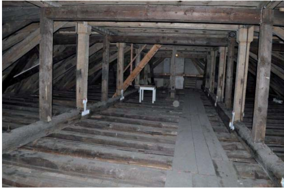
Abb. 71: Blick in den Dachstuhl über dem Kaisersaal.
