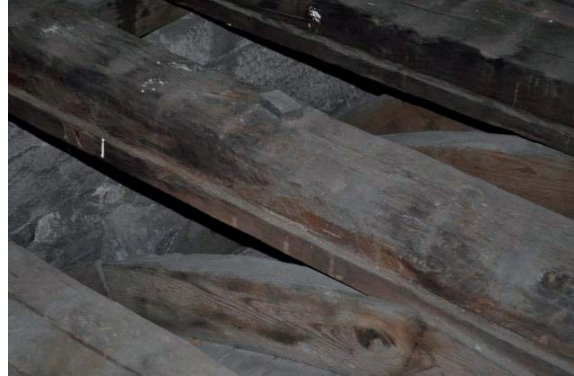
Abb. 72: Deckenbalken und Spanten der Kehle der Kaisersaaldecke.
