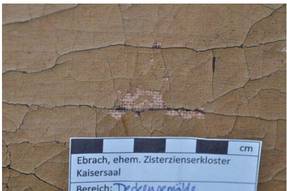
Abb. 168: Dreckspur in ehem. Craquelé-Riss.
