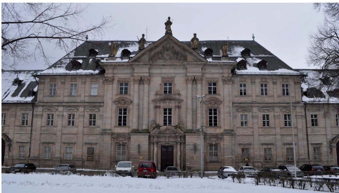
Abb. 21: Treppenhausbau der Nordfassade des ehem. Klosters.
