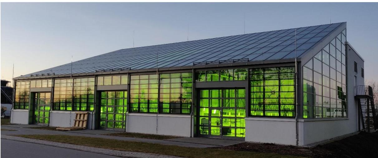
Abbildung 4.1. Außenansicht des Algentechnikums von der Südseite bei grüner LED-Beleuchtung in drei separaten Klimasimulationshallen sowie dem angeschlossenen Labortrakt (Erdgeschoss) mit Klimazentrale (1. Stock) auf der Nordseite.
