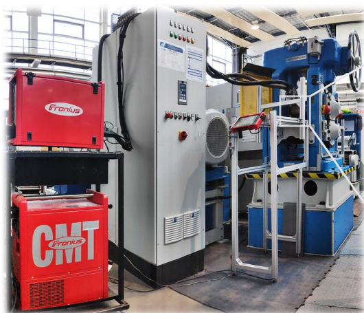
Integration der Schweißmaschine in das bestehende Walzgerüst
