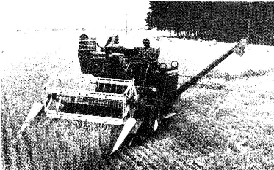
11) „McCormick International“-Mähdrescher der Mittelklasse mit Korntank und mit Absackvorrichtung an der Körnerschnecke, um das Korn wahlweise lose oder im Sack hergen zu können (International Harvester Company mbH., Neuss Rhein)
