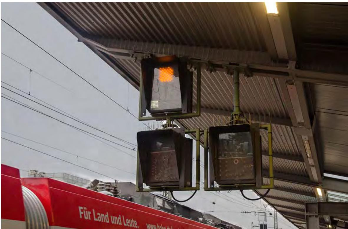
**Abbildung 4.22:** Befestigung mehrerer Zusatzanzeiger an der Dachkonstruktion eines Bahnsteiges
