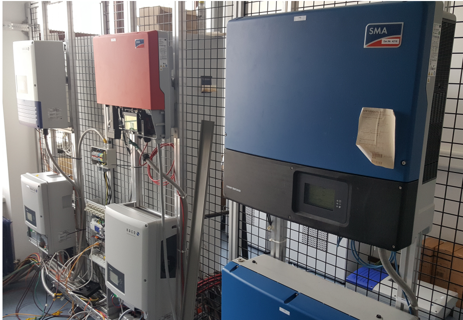
Abbildung 3.5. – Im Labor eingesetzte Wechselrichter verschiedener Hersteller
