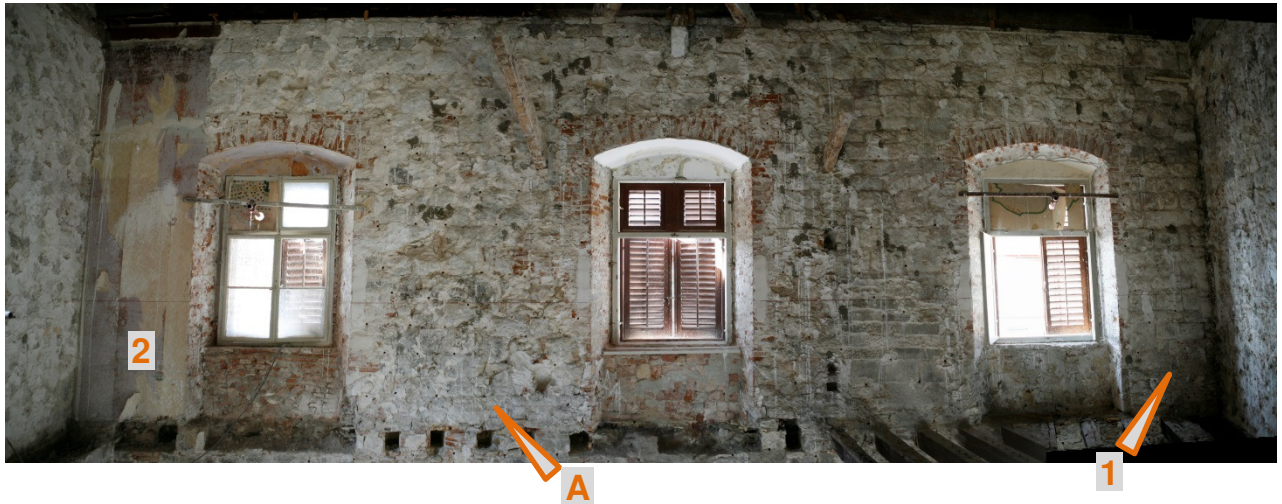
Bild 228 Westliche Fassade, erster Stock 505
