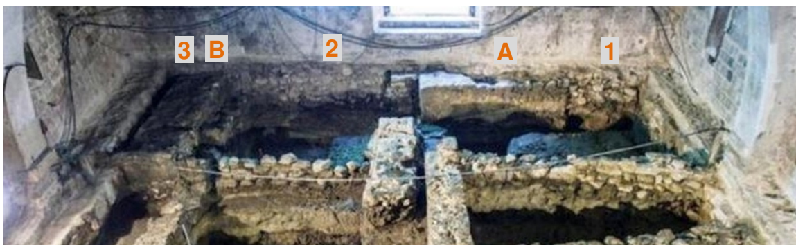
Bild 103 Die östliche Fassade und das 8. Joch 395
