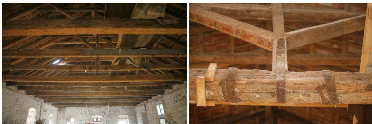
Bild 244 Der westliche Teil (Bausanierungsperiode) 517 Bild 245 Detail: Hängender Träger (Typ A) 518
