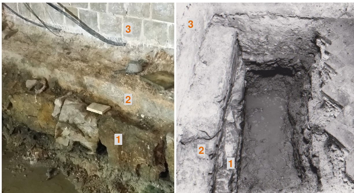
Bild 98 Der östliche Teil – Das südliche Fundament (8. Joch) Bild 99 Das Arsenalfundament (Fontik-Innenraum) 394
