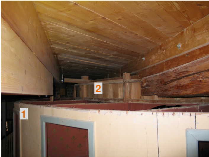
Bild 237 Verbindung mit dem Dachwerk Bild 238 Theater: Stockwerksverbindung mit den seitlichen Mauern
