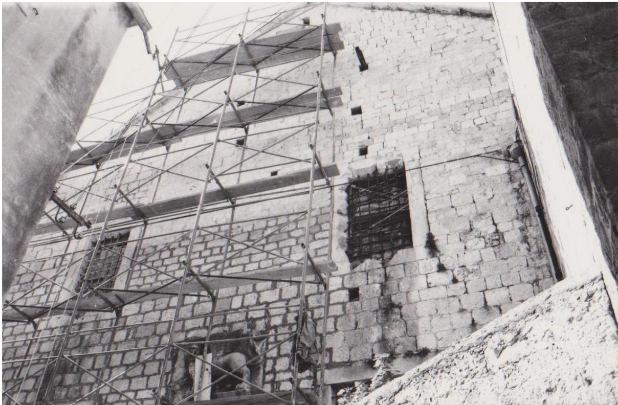
Bild 43 Sanierung der östlichen Fassade, 1988 222
