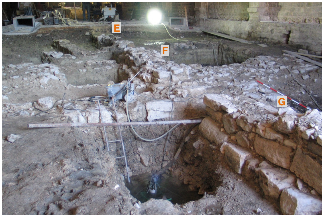
Bild 123 Der westliche Teil des Erdgeschosses (2015)
