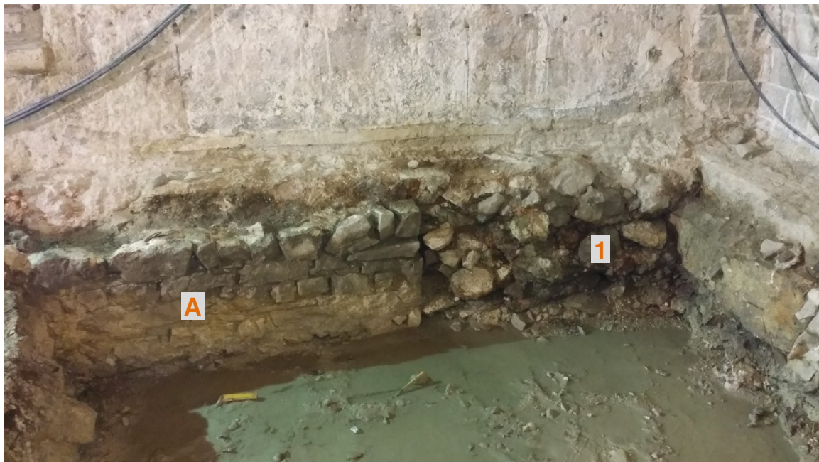
Bild 104 Die östliche Fassade; die südliche Hälfte
