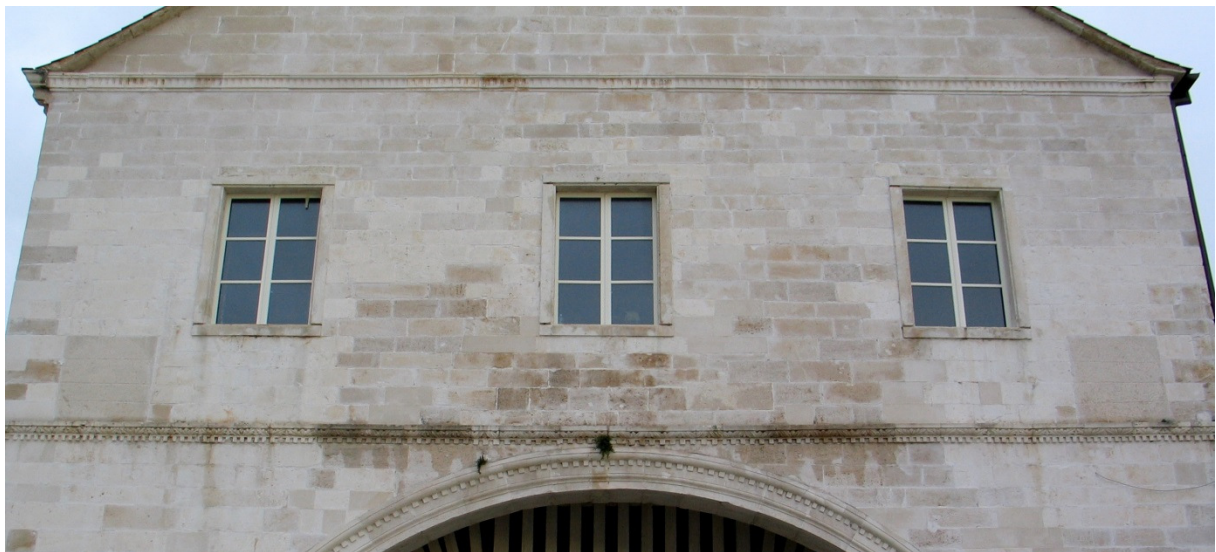
Bild 209 Ehemaliges „Andante“- Relief an der westlichen Fassade Einheit 4
