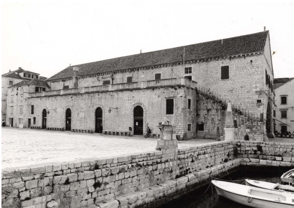
Bild 23 Fontik / Nordfassade 126 (Zustand vor der Bausanierung - 1996)
