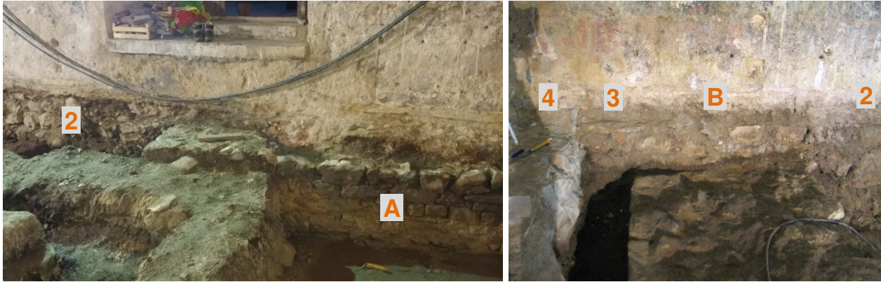
Bild 105 Die Mitte der östlichen Fassade Bild 106 Die innere nordöstliche Ecke des Arsenal
