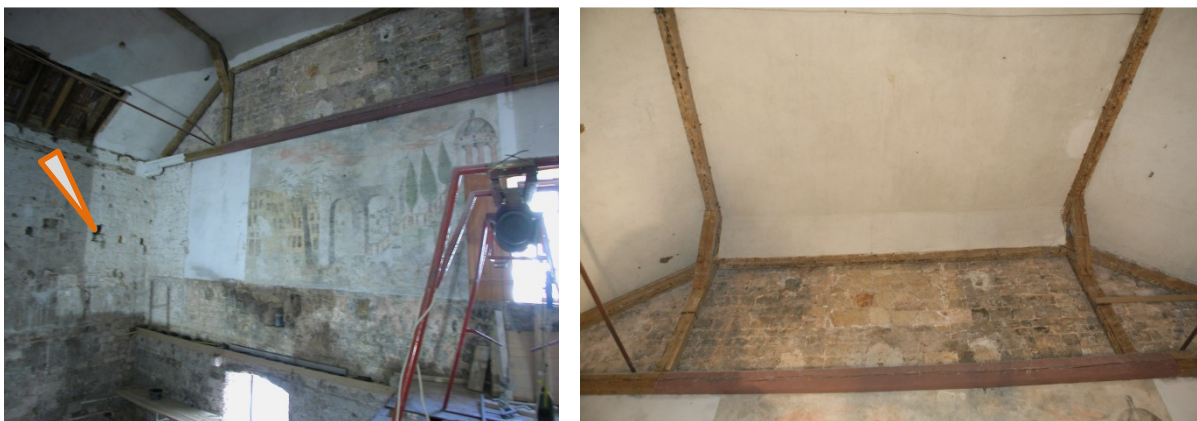
Bild 248 Nordöstliche Ecke 519 Bild 249 Hängender Träger; östliche Fassade 520
