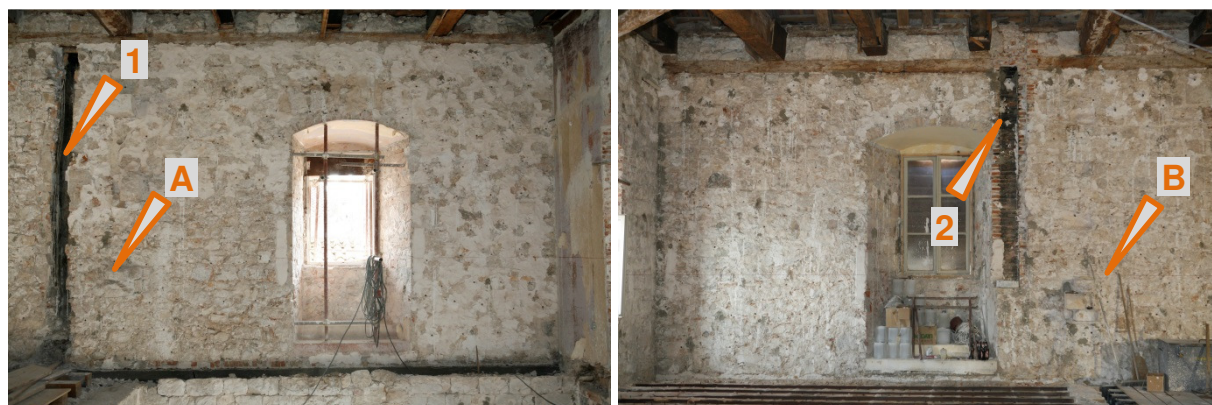
Bild 226 Erstes Joch, erster Stock, südliche Mauer 503 Bild 227 Erstes Joch, erster Stock, nördliche Mauer 504
