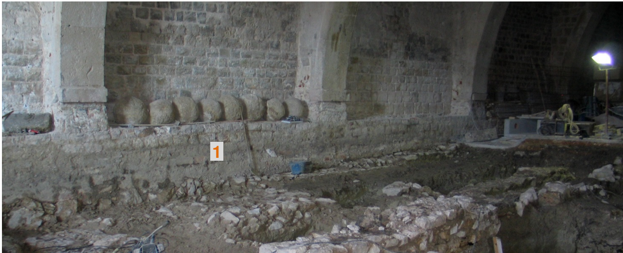
Bild 102 Das nördliche Fundament (3. und 4. Joch)
