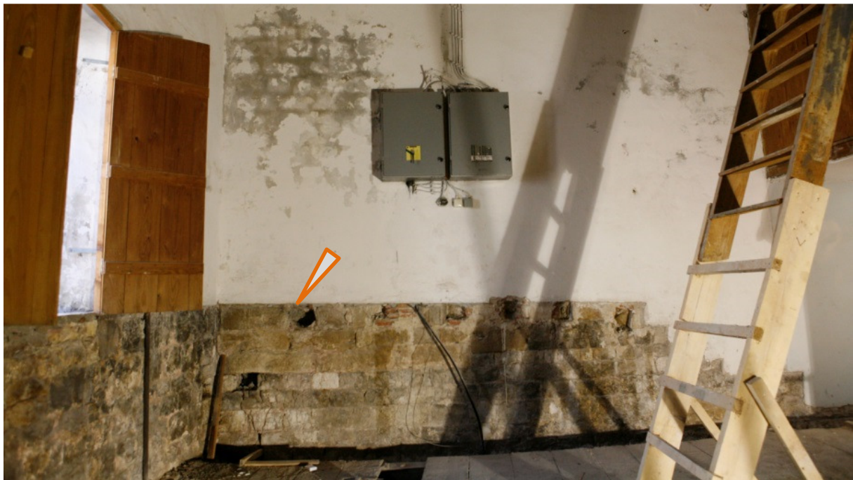
Bild 240 Feuerspuren unter der Bühne 512
