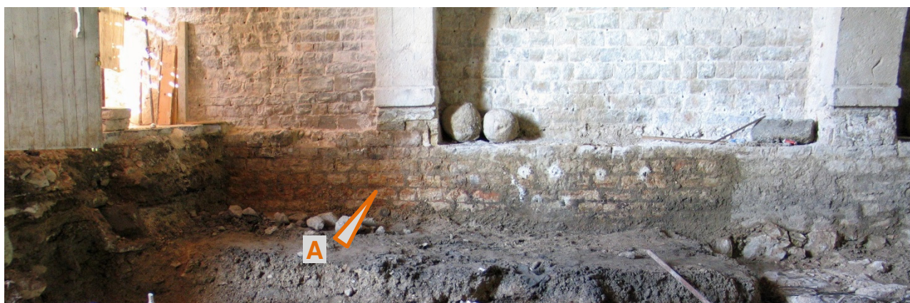
Bild 108 Die nördliche Mauer und das nördliche Fundament (1. Und 2. Joch)
