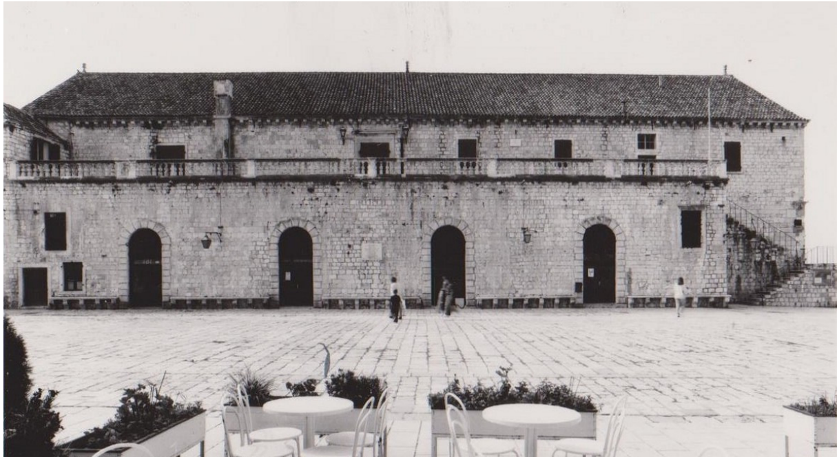
Bild 38 Arsenal, Nördliche Fassade: Zustand 1994, vor der Bausanierung 203
