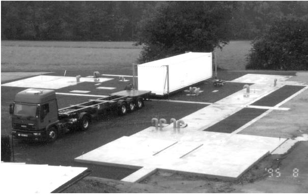
Abb. 4.3: Vorbereitete Plattform für TIGO (in Wettzell). Unterirdische Kabelschächte verbinden die Sensorplattformen mit den Containerstandorten.
