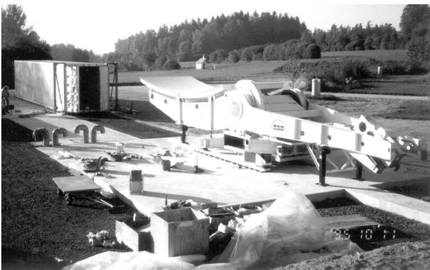
Abb. 4.5: Der leere Transportcontainer wird mit Greifzug weggezogen, so daß das Radioteleskop frei auf der Plattform steht.
