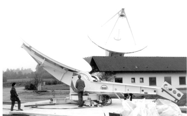
Abb. 4.8: Mit Motorkraft wird der Reflektor hochgefahren, so daß die Empfängerbox mit dem Feed in den Brennpunkt kommt.
