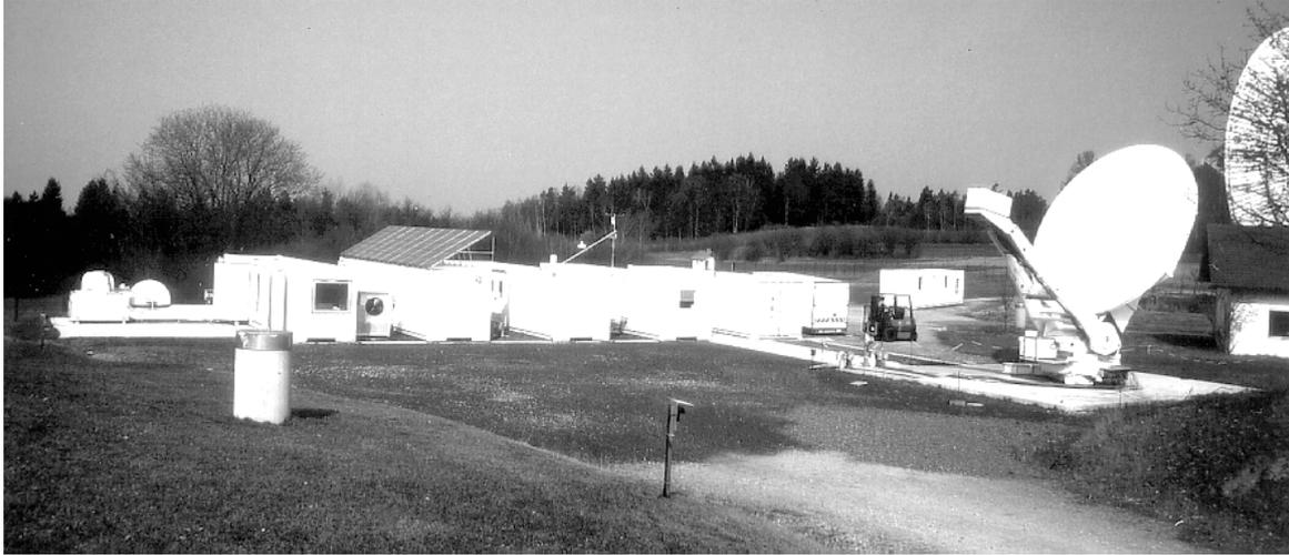
Abb. 4.2: TIGO während der Inbetriebnahme auf der Meßplattform in Wettzell, 1998. Links befindet sich das SLR-Teleskop, im Vordergrund ein GPS-Pfeiler. In der Mitte erkennt man die Solarpanele und daneben die Wettersensoren. Hinter dem Gabelstapler steht der Generatorcontainer. Rechts befindet sich das Radioteleskop für VLBI-Beobachtungen.
