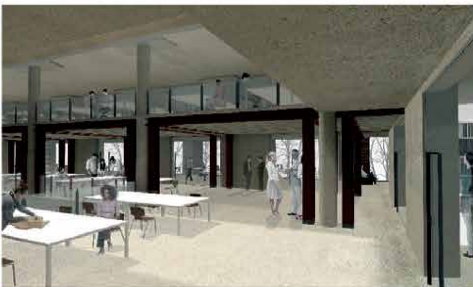
1. OG Westende Der ursprünglich zweigeschossige Mensaal bekommt eine Zwischendecke eingesetzt welche auf einer Stahlkonstruktion aus Stützen und starken IPB Trägern lagert. Die Doppelfassade aus Glas und Beton hinter den sich die Arbeitsbereiche der Lehrstühle befinden sind einerseits ruhiger Bereiche zum arbeiten am Computer und Büchern zum anderen auch aus dem Gebäudeinneren den Blick ins Freie an.
