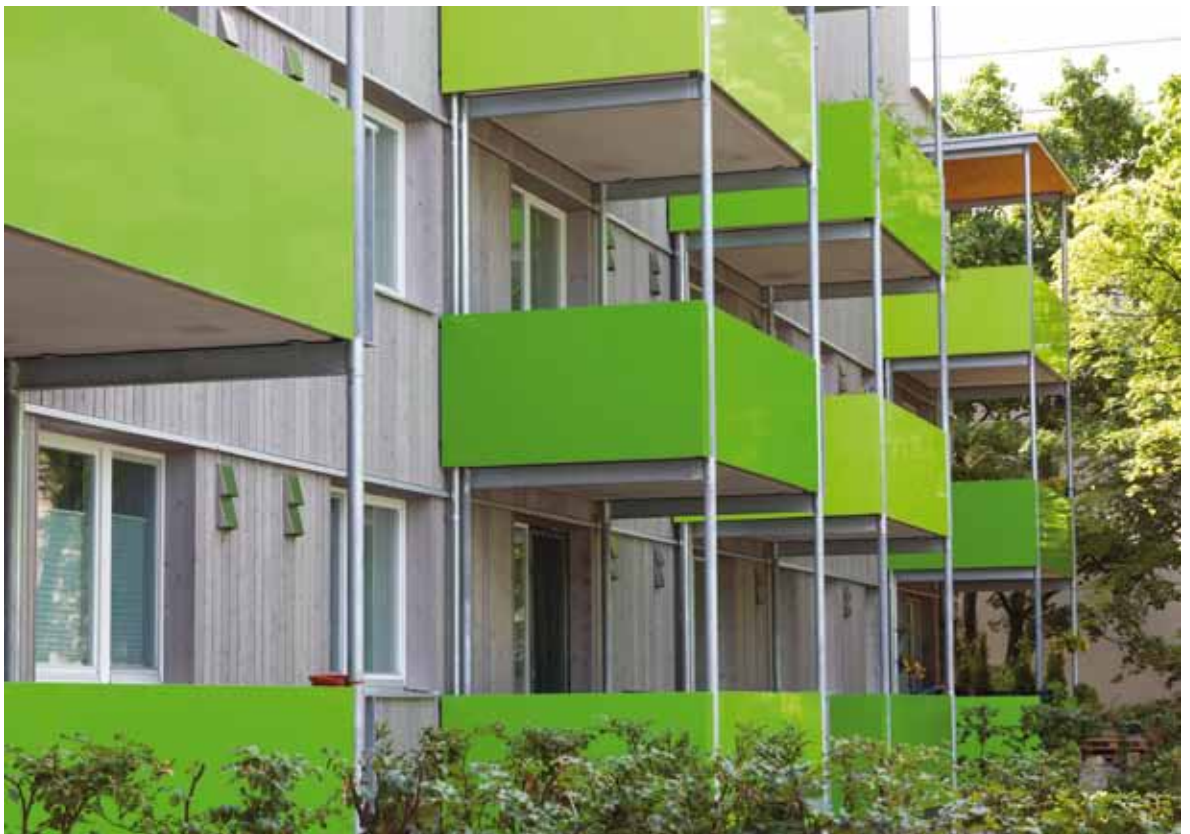
Fassadenmodernisierung, horizontale und vertikale Erweiterung eines typischen Nachkriegsgebäudes in München Sendling Facade modernization, horizontal and vertical extension of a typical post-war building in Munich-Sendling Pilotprojekt Fernpassstrasse Architektur ARGE Kaufmann Lichtblau Pilot project in the Fernpassstrasse, architectural collaboration between Kaufmann und Lichtblau, Fotos: Stefan Müller-Naumann
