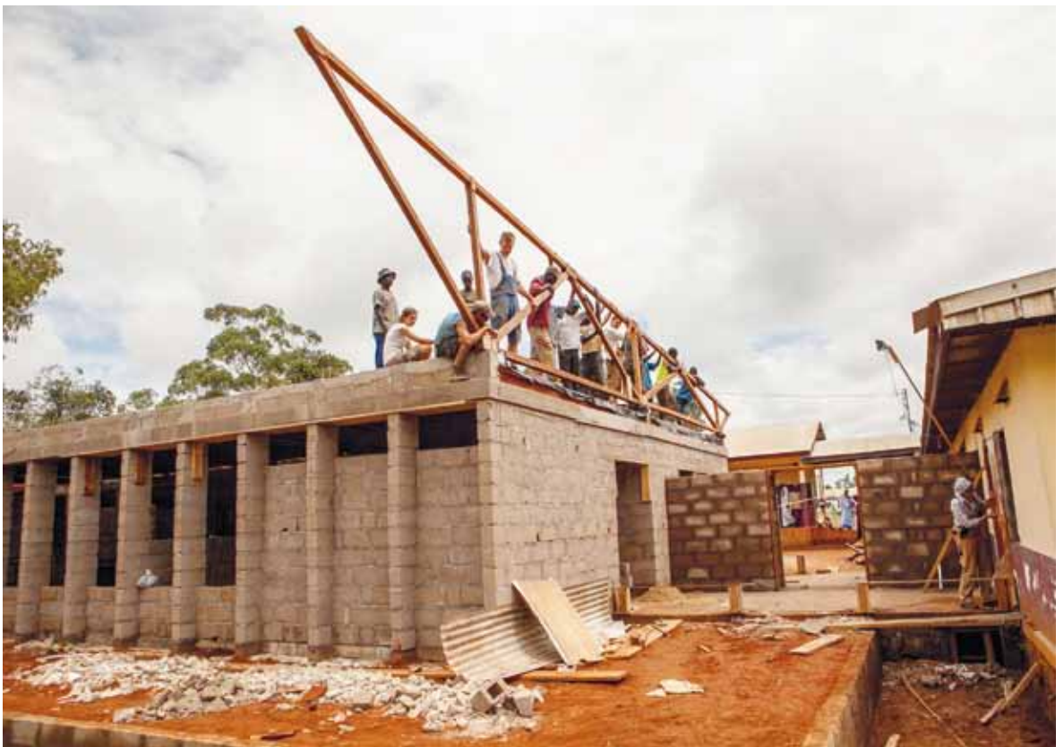
Vorderansicht des neuen Operationsgebäudes Front elevation of the new operating theatre building Aufstellen des ersten Nagelbinders der Dachkonstruktion Erection of the first nailed truss of the roof construction Fotos: Matthias Kestel
