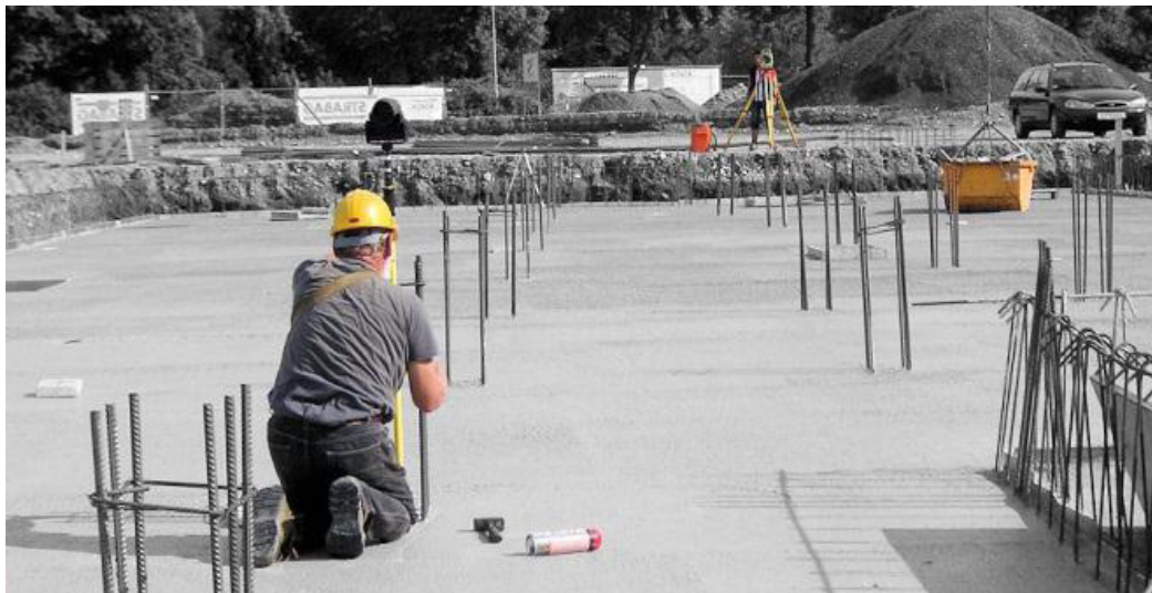
Abb. 3: Absteckung und Kontrolle (Foto: Vermessung ZT Kollenprat, Klagenfurt, 2012)
