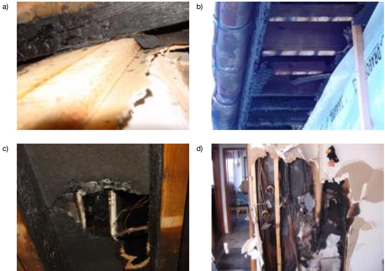
Abbildung 13: Beispiele zu Brandweiterleitungspfaden
