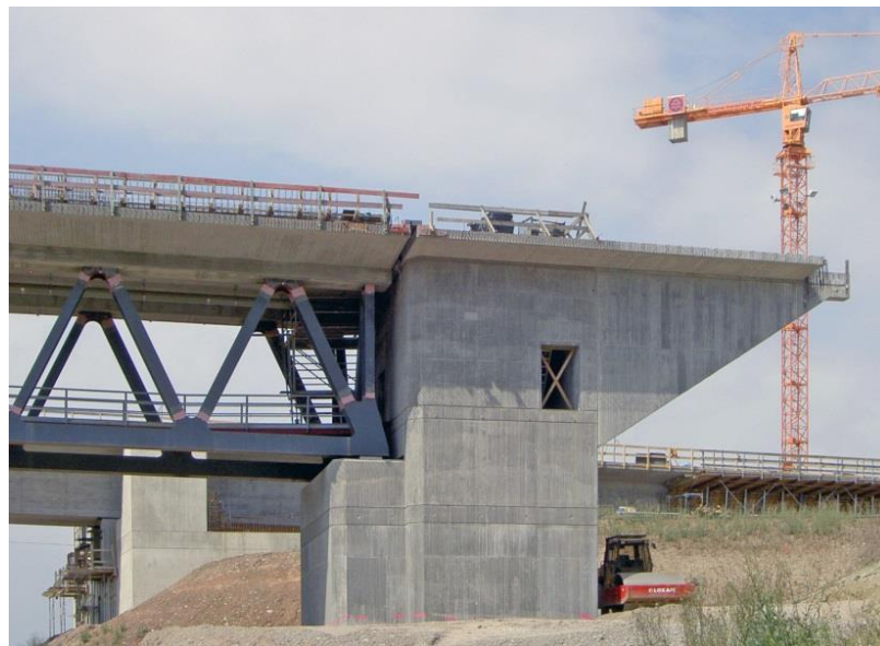
Abbildung 22: Ein kastenförmiger Pfeiler im Bauzustand [19]
