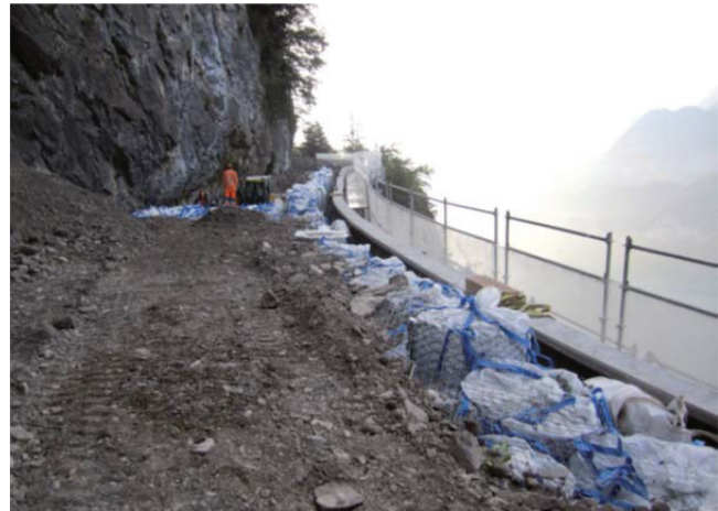
Abb. 14: Installation des Horizontalgeflechts auf den Modulen und Abschluss mittels Kiesschüttung darauf.
