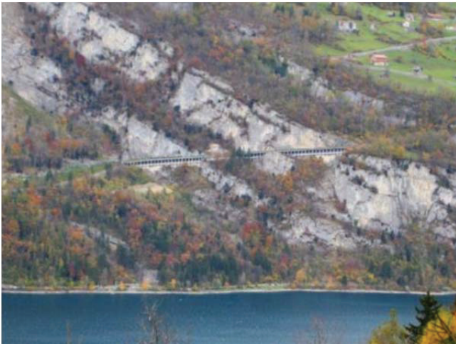
Abb. 9: Ansicht Steinschlagschutz-Galerien Mattstock und Churfürsten, Amden, Schweiz.
