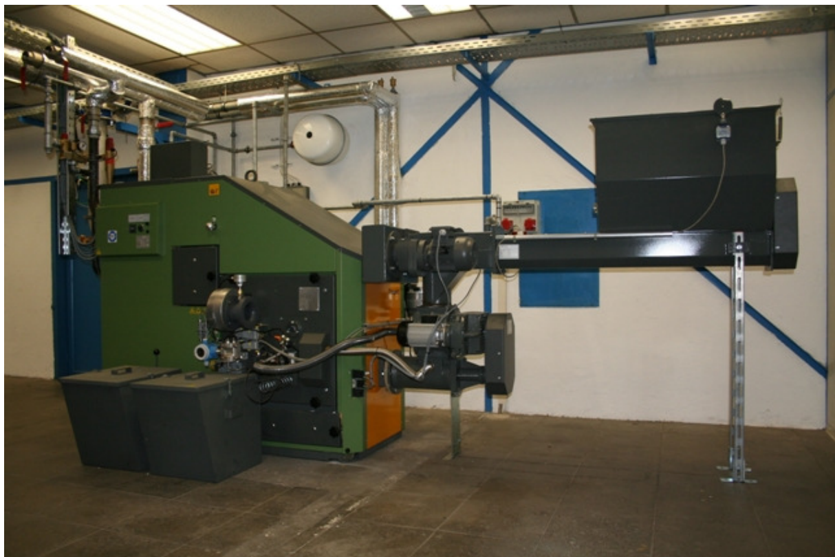
Abbildung 37: 100 kW-Rostfeuerung
