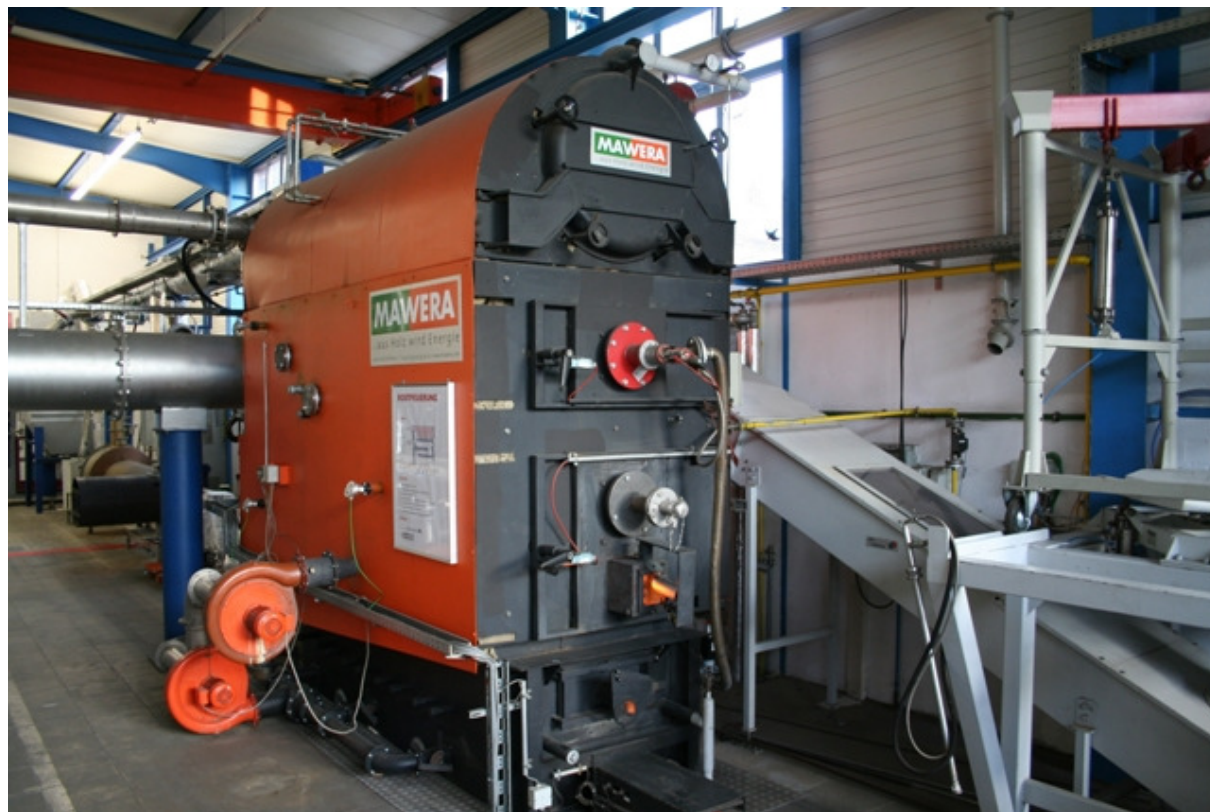
Abbildung 39: 440 kW-Rostfeuerung
