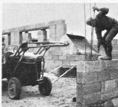
Abb. 615 Mantelbetonsteinbauweise
