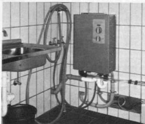
Abb. 381 Programmgesteuerter Spülautomat zur Reinigung von Rohmelkanlagen
