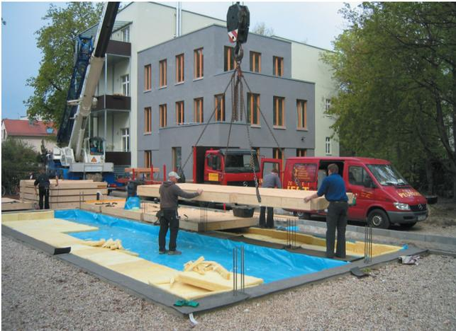
**Abb. 1: Verlegung einer Holzbodenplatte über Kriechkeller mit Streifenfundament**
