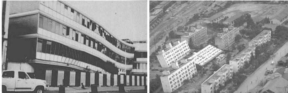
Abb. 3-8 Schadensbilder bei Erdbeben (links: Torsionsversagen, rechts: Bodenverflüssigung)
