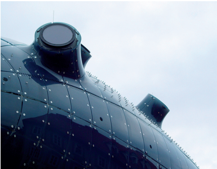
Abb. 1.1: Kulturhaus Graz, Beispiel für komplexe Gebäudegeometrie. Quelle: [jrmel 2006]
