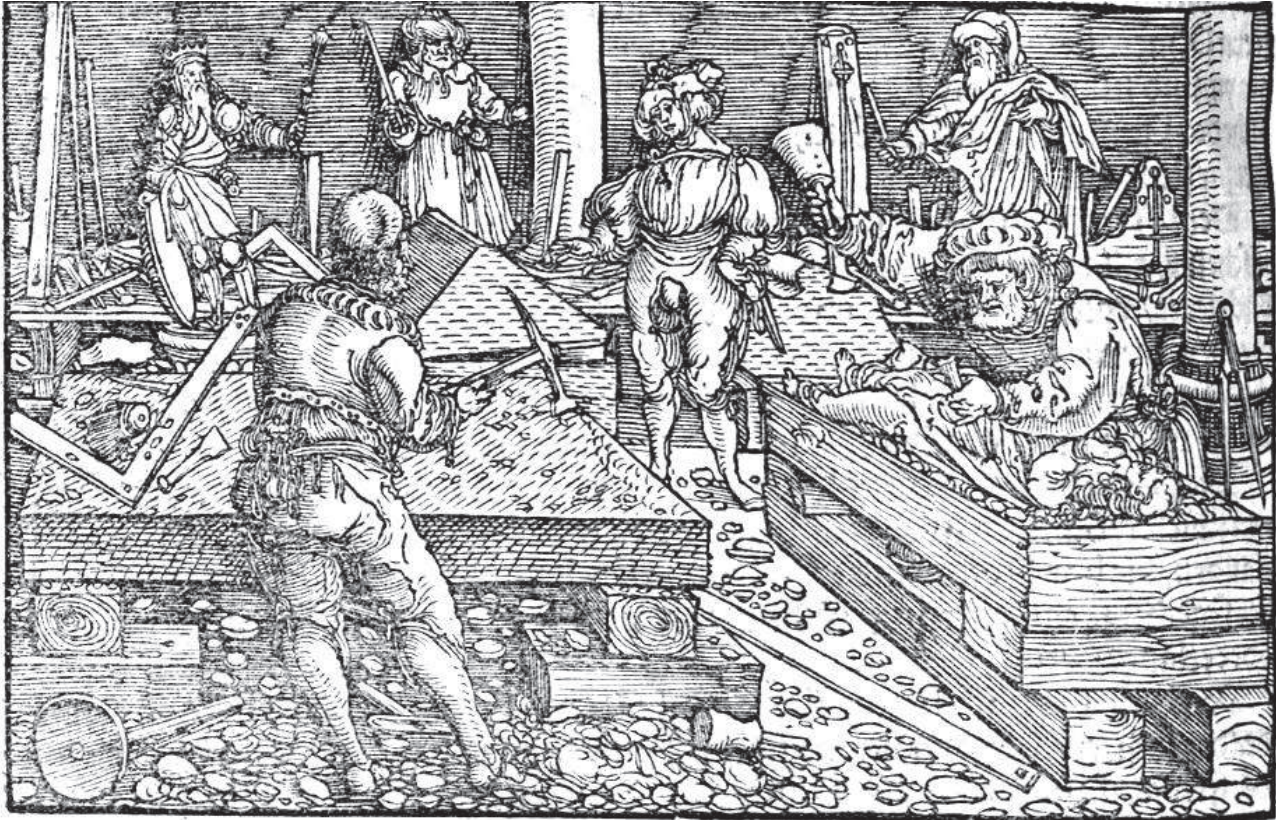
POLYDORUS VERGILIUS: Von den Erfindern dyngen, Augsburg 1537, Res/2 Alch. 18, Kap. 23, BSB: Steinbildhauer bei der Arbeit: Meißel- und Klüpfelverwendung
