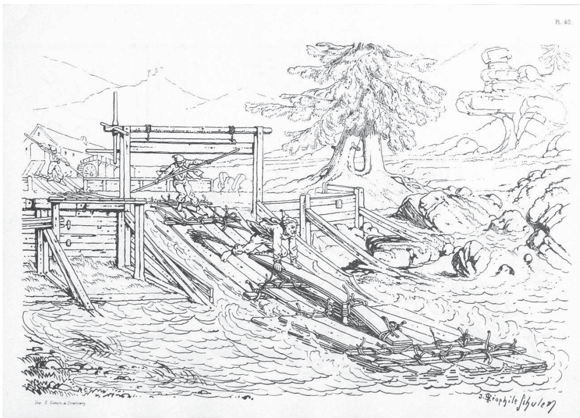
A.MICHIELS, TH. SCHULLER: Les Bucherons et les Schlitteur de Vosges, Strasbourg 1857, Pl. 40: Brettfloß bei der Durchfahrt eines Stauwehres
