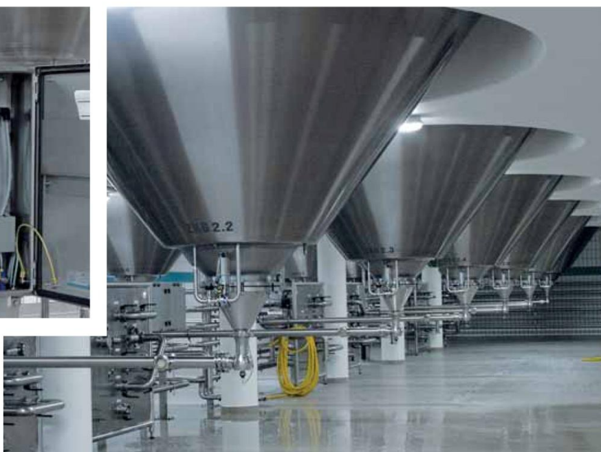
Klassische Hybridindustrie-Brauerei: Prozessautomation mit CPV Feldbus- ventilinseln im Biergärkeller.
