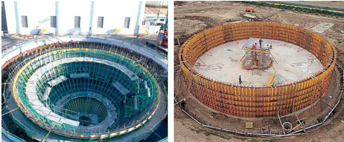
Abbildung 2-7: Beispiele zu rotationssymmetrischen Sonderschalungen (Foto links: Fa. RSB, aus [F.3], Foto rechts: Fa. PERI, aus [F.4])
