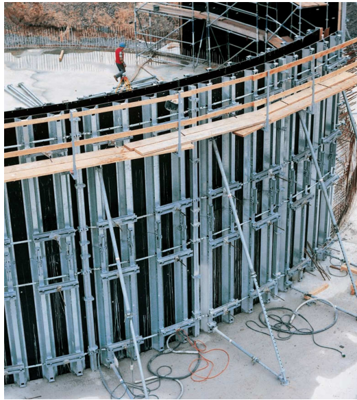
Abbildung 2-2: Trägerschalung mit flexibler Schalhaut (Firma Hünnebeck [F.2])
