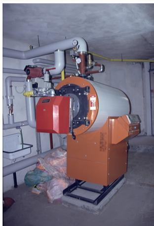
Abbildung 6.21: Im Heizraum steht entweder ein direkter Luftheizer (oben) oder ein Heizkessel (unten), der die Wärme des Heizwassers über einen zentralen Wärmetauscher oder in einzelnen Wärmestationen an die Kirchenluft abgibt
