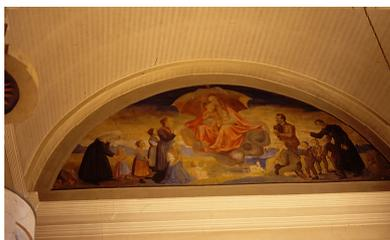
Abbildung 6.11: Die Schwärzung in der mit Bankheizung temperierten Kirche in Maria Saal am Ritten/Südtirol zeichnet die Struktur der Deckenkonstruktion nach.
