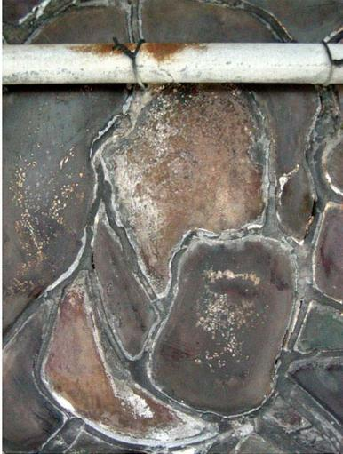
Abbildung 2.13: Detail einer Glasmalerei aus dem 14. Jh (Wells, Cathedral of St Andrew). Die ins Glas geätzten Korrosionslöcher, Korrosion an Glas und Bleirute und Ablagerungen sind in der von außen gemachten Auflichtaufnahme deutlich zu erkennen [Rauch, 2004]
