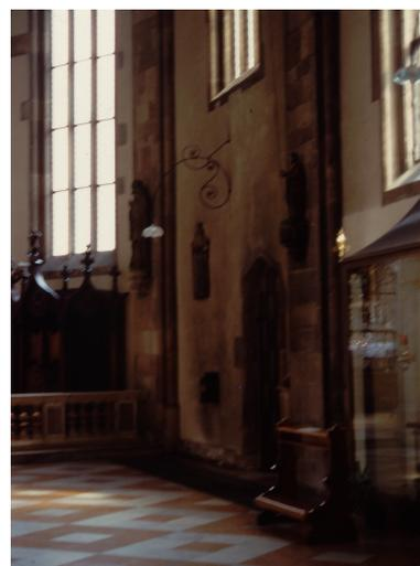
Abbildung 4.10: Schmutzfahne über dem Warmluftauslass im Bozner Dom
