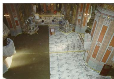
Abbildung 6.24: Verlegen der Fußbodenheizung in der Pfarrkirche von St. Ulrich in Gröden
