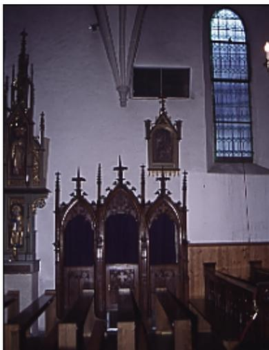
Abbildung C.19: Zuluftgitter über dem neugotischen Beichtstuhl
