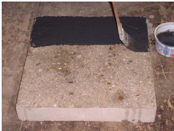
**Bild 6.7: Aufpinseln der Mikrosilikasuspension ca. 10-20 min vor dem Aufbringen des Neubetons**
