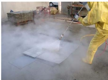
**Bild 4.1: Höchstdruckwasserstrahlen von Altbetonplatten**
