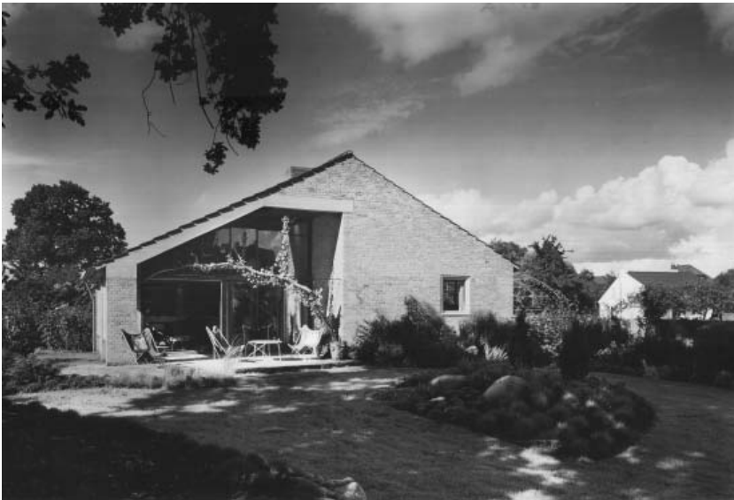
40. 28 Wohnhaus Ernst May, Straßenansicht. 41. 28 Wohnhaus Ernst May, Gartenansicht.
