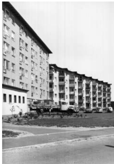
13. 3 Siedlung Grünhöfe, realisiertes Gebäude Auf der Bult / Boschstraße.
