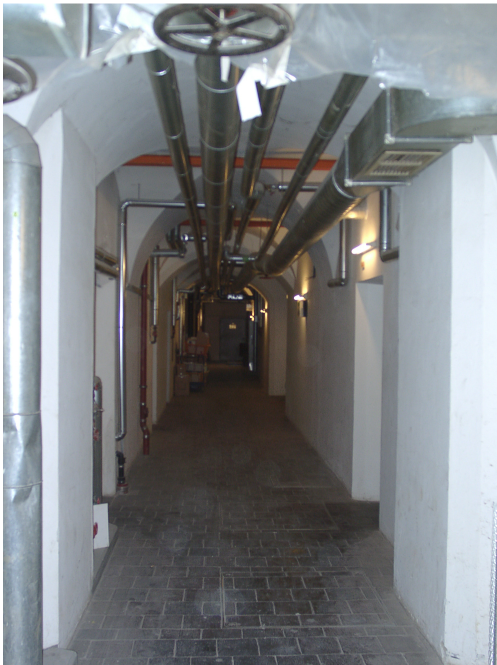
Bild 1 : Flur im ersten Kellergeschoss des Rathauses
