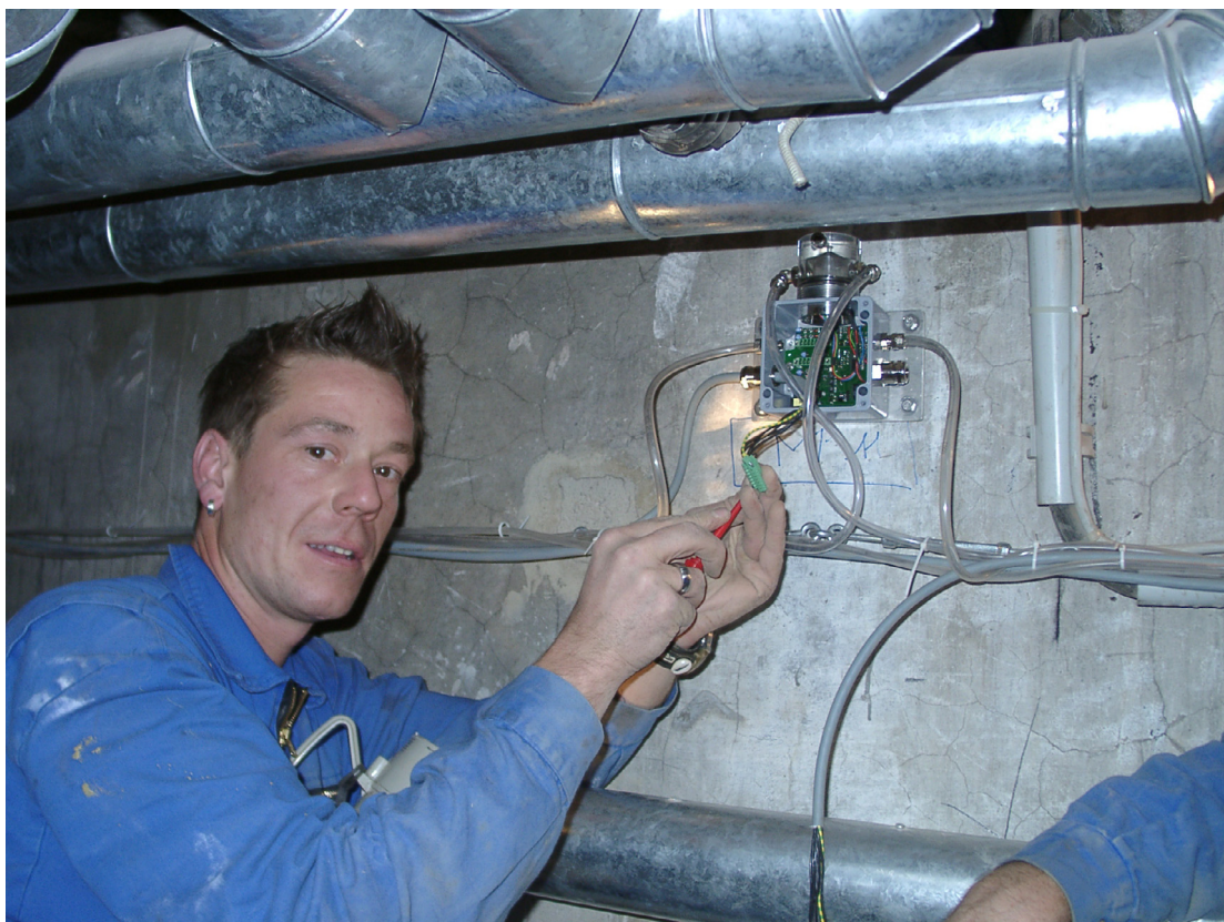
Bild 4: Montage einer Messstation
