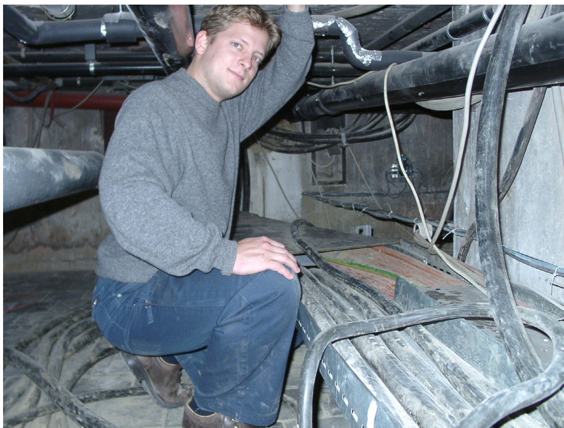
Bild 3: Blick in den Kriechgang unterhalb des ersten Kellergeschosses, Hauptachse
