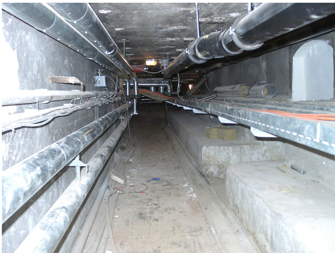
Bild 2: Blick in den Kriechgang unterhalb des ersten Kellergeschosses, Querachse Süd
