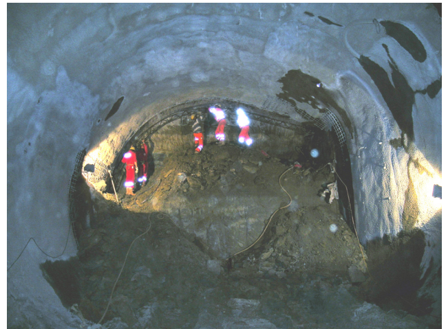
Abb. 10-9: Stellen eines Ausbaubogens
