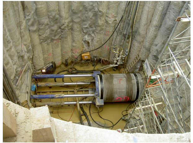
Abb. 10-7: Rohrvorpressung
