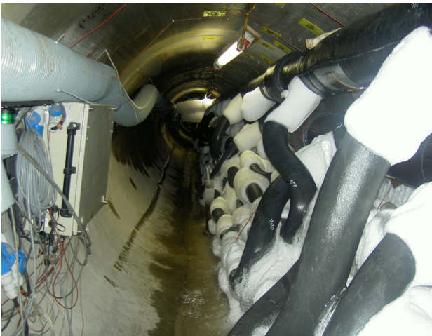
Abb. 10-8: Blick in den Pilotstollen
