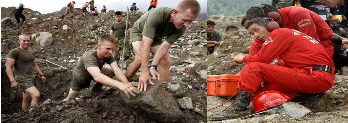
Abb.6-030: Rettungsarbeit beim Schlammstrom auf den Philippinen [INTERNET 35]
