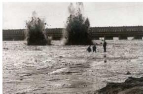
Abb.6-039: Zerstörung eines Eisdamms durch Sprengung [YAN et al. 2005b]
