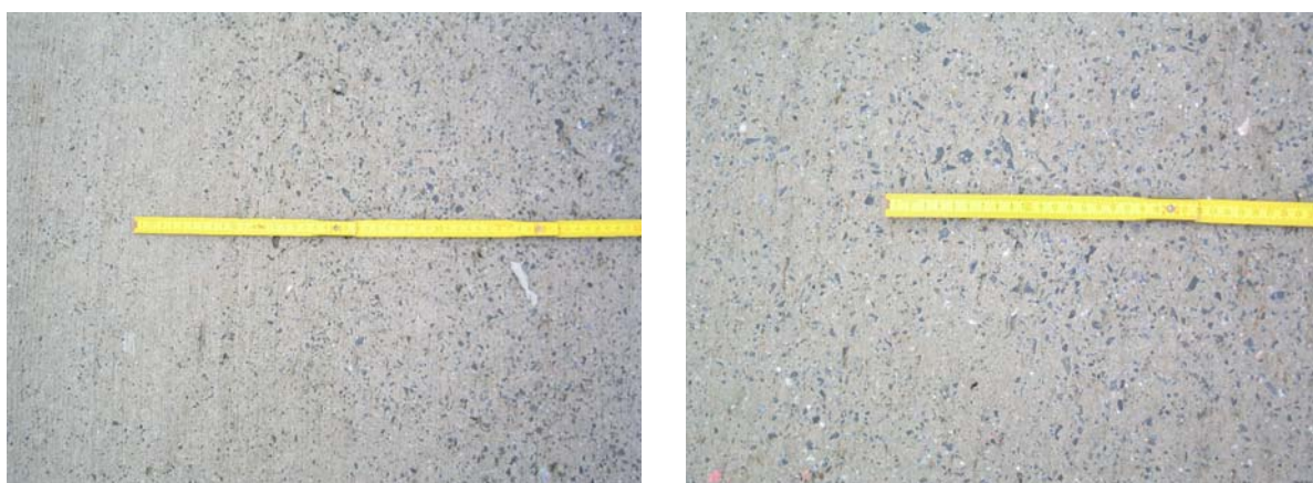
Bild 32: links: Besenlängsstrich im Beton A44_B 35 nach 5 Jahren Liegezeit rechts: Jutetuchlängsstrich im Beton A44_B 35 nach 5 Jahren Liegezeit
