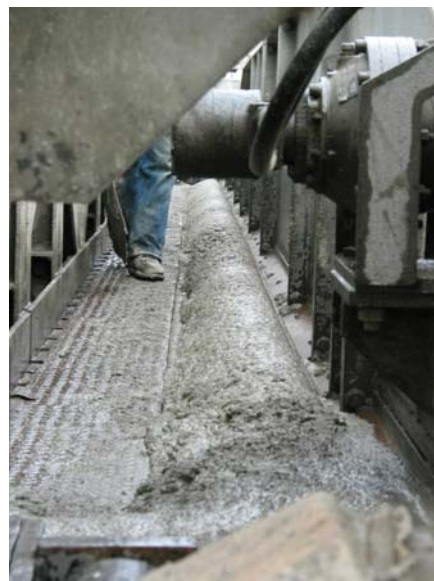
Bild 39: Ausgeprägte Mörtelansammlung vor dem Querglätter beim Betoneinbau auf der BAB A92
