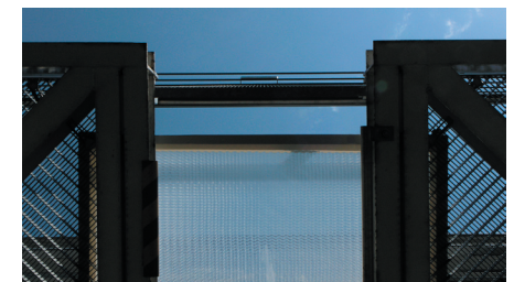
Abb.7-2: MMK-Bauteil auf dem Dach
