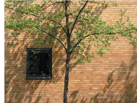
Ansicht des Nachbargebäudes an der TUM
