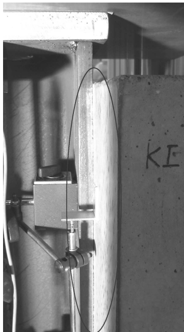
Abbildung 3.38: Gurt KI5.1.1 – Fugenöffnung über die gesamte Gurthöhe oben im Bereich der Höchstlast
