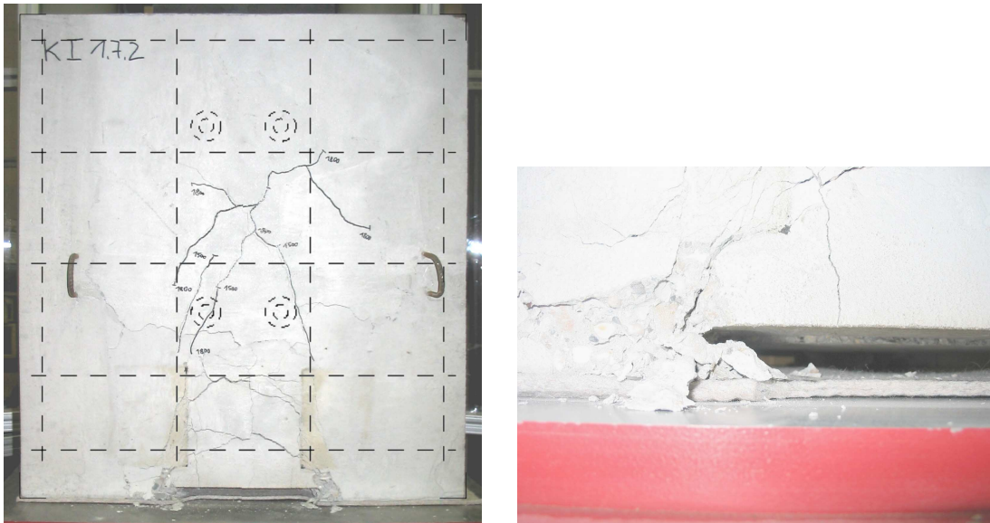
Abbildung 3.49: Ansicht Gurt KI1.7.2 nach dem Bruchversuch (links) und Detail linke untere Ecke der Betonaussparung (rechts)
