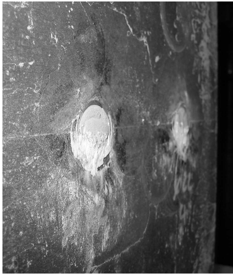
Abbildung 3.63: Abscheren der Kopfbolzen mit abgedrehtem Wulst in der Grenzfläche zwischen Stahlgurt und Bolzenschaft
