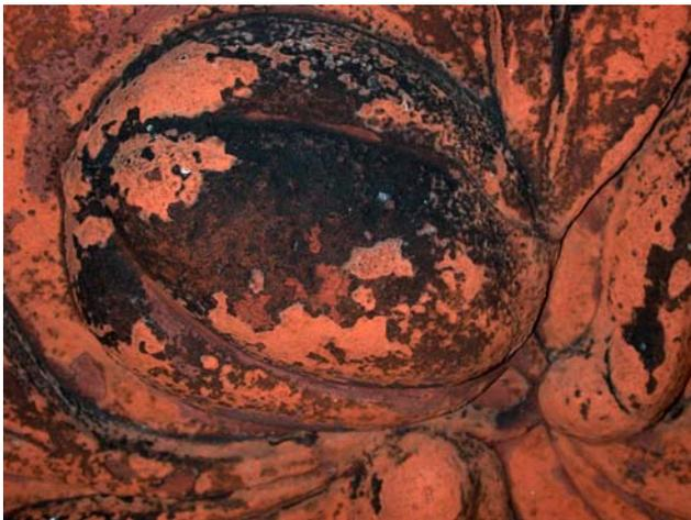
Abb. 8a: Schloß Schwerin, Südfassade, Verlust der originalen Oberfläche durch Abplatzen von schwarzen Krusten.
