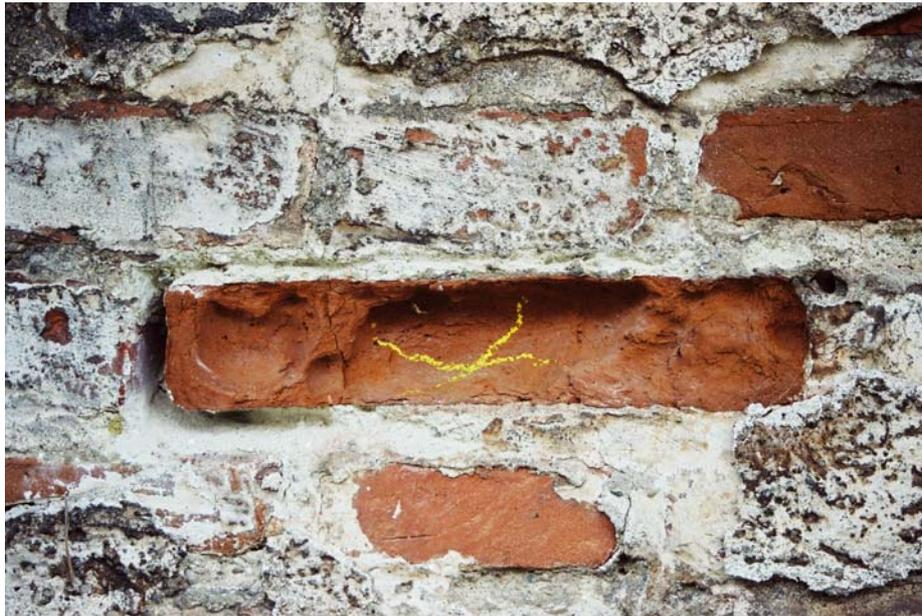
Abb. 105: Geschädigter niedrig gebrannter Ziegel im Verbund.
