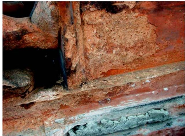
Abb. 8b: Feldafing, Roseninsel, figurale Brüstungswangen aus Terrakotta, Südterrasse, Detailaufnahme. Aufblättern des Gefüges durch Einwirkung von leichtlöslichen Salzen (Alkali und Erdalkalinitrat).
