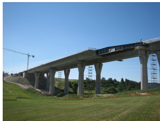
b) Sulzebachtalbrücke im Bauzustand, Baujahr 2007
