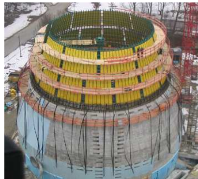
d) Faulbehälter Gut Großlappen im Bauzustand, Baujahr 2007 (Quelle: www.arge-ggl.de )
