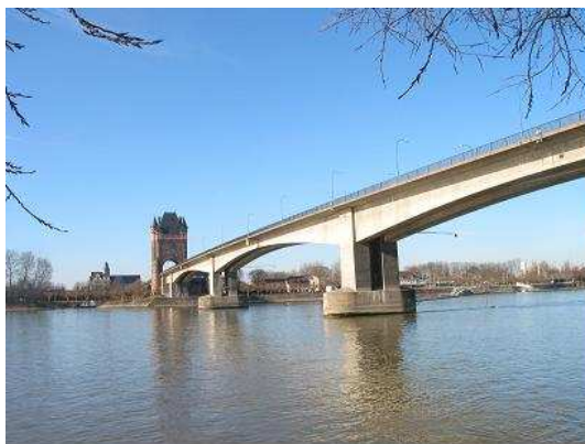
a) Rheinbrücke Worms, Baujahr 1953 (Quelle: Keuser)
