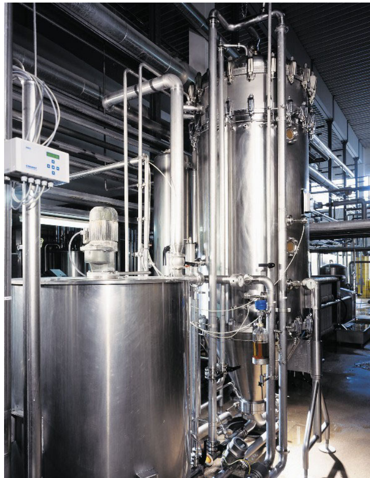
Abbildung 6.7: TFS-Filter (Umbau) Typ 1100/26,6
