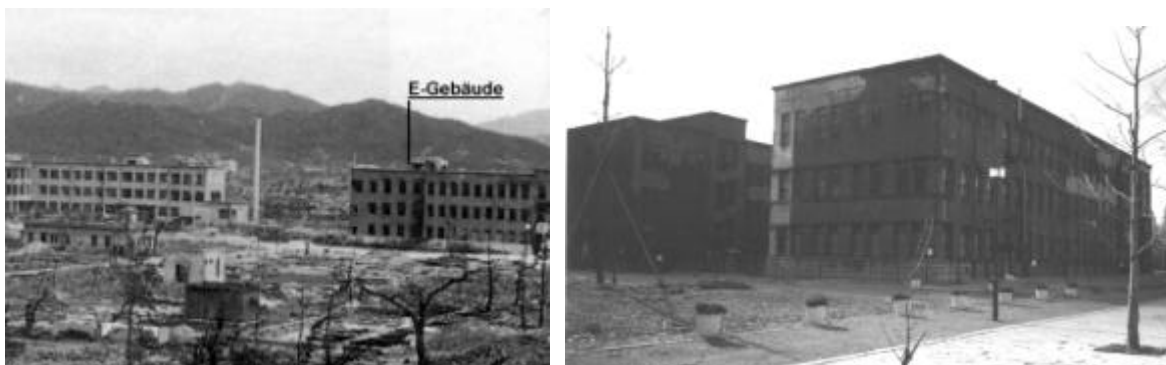
Abb. 2.8: Südseite des E-Gebäudes Oktober 1945 (links) [CoH96]. Nordecke des E-Gebäudes Dezember 2000 (rechts).
