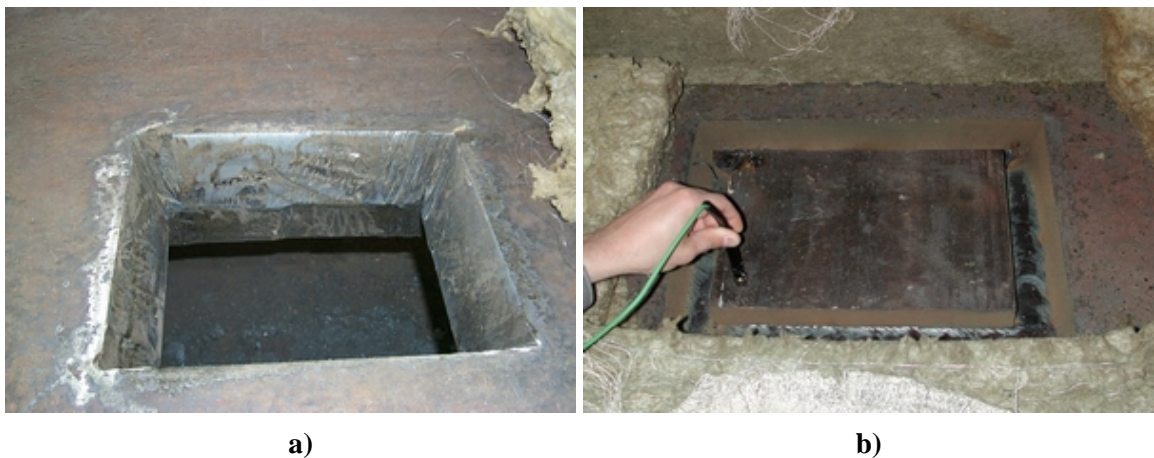
Abbildung 6. a) Brammenausnehmung mit abgeschrägten Seiten für K-Naht Schweißung b) Implantblock während der Einschweißung - Temperaturkontrolle
