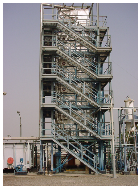
Abbildung 13: Umm Al Naar Entsalzungsanlage bei Abu Dhabi: Solarthermische Meerwasserentsalzung mit über einhundert Kubikmetern Tagesproduktion (Multi Effect Destillation)
