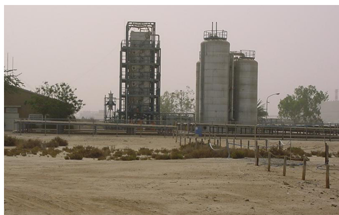
Abbildung 13: Umm Al Naar Entsalzungsanlage bei Abu Dhabi: Solarthermische Meerwasserentsalzung mit über einhundert Kubikmetern Tagesproduktion (Multi Effect Destillation)
